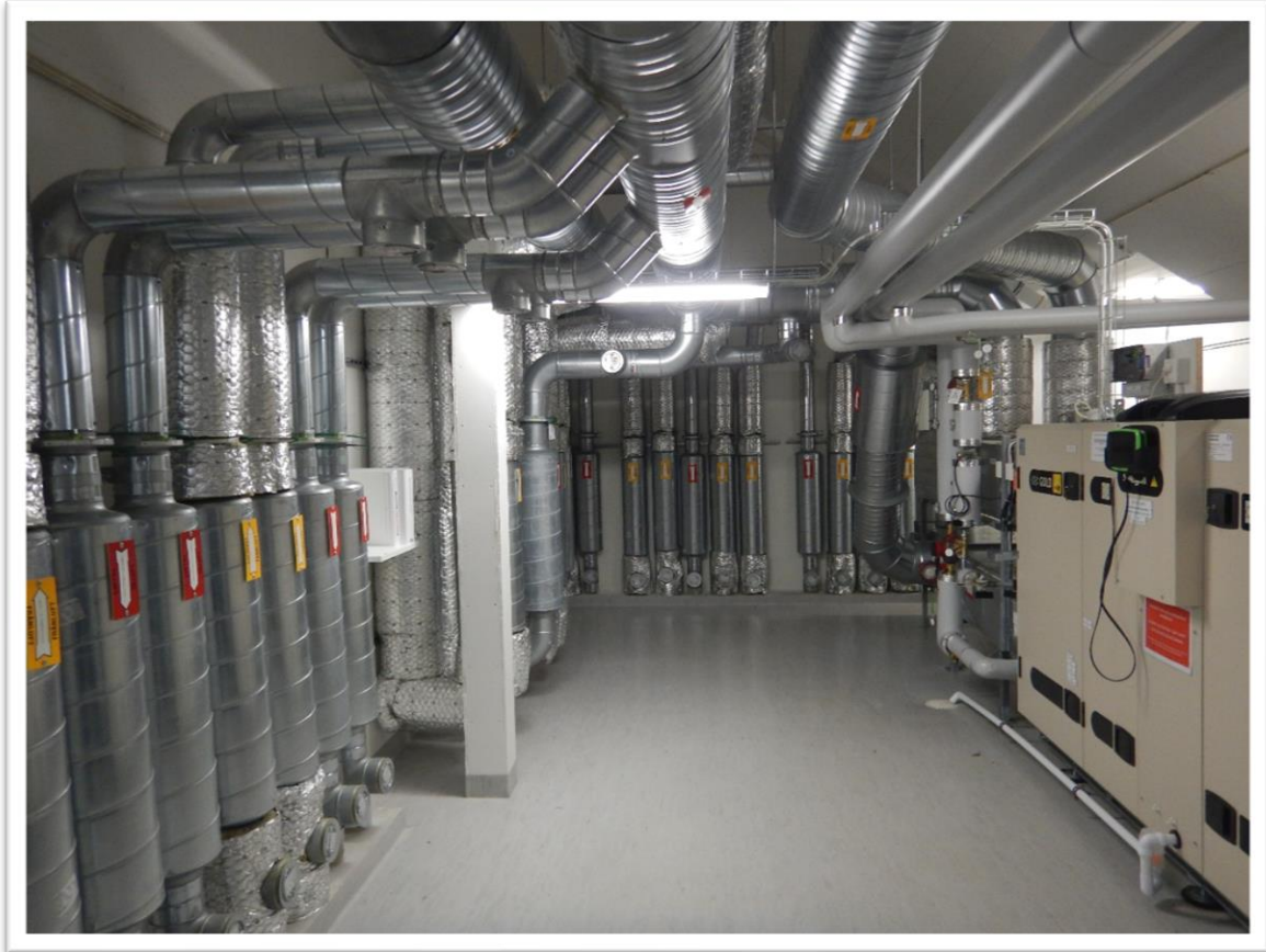
Figur 22. Fläktrum med god möjlighet att mäta luftflöden till och från lägenheter.
