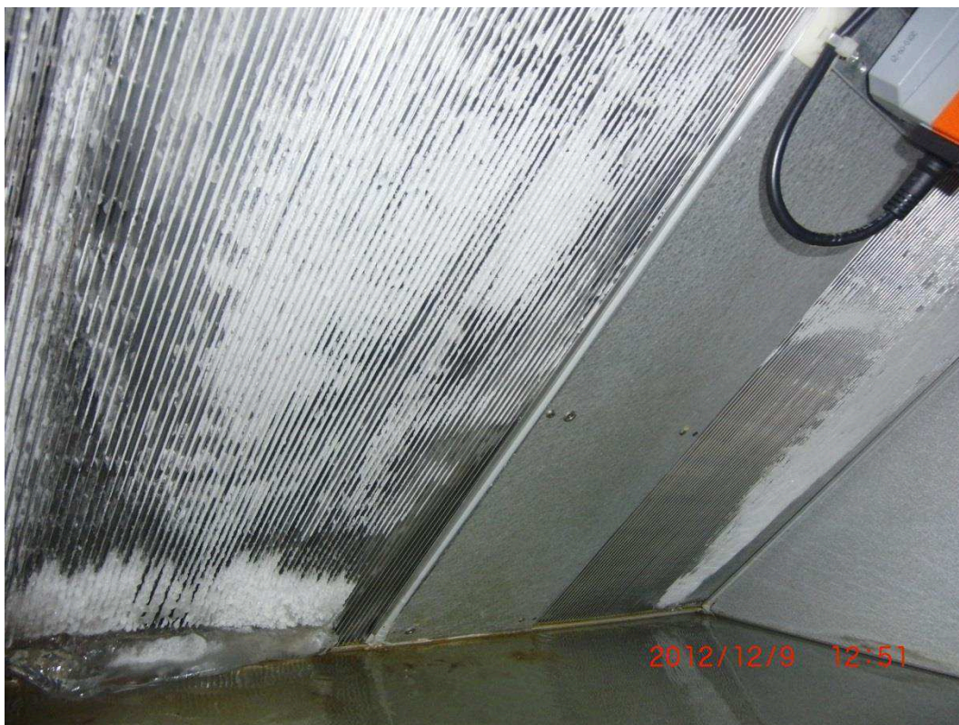
Figur 3 Exempel på batteri med påfrysning i värmeväxlaren, när det är kallt ute och man inte har en förvärmning etc. Bild från Bengt Bergqvist, Energianalys AB.
