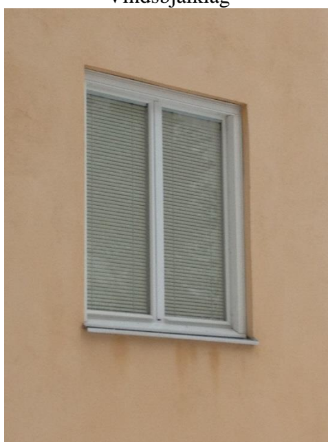
Fuktfläckar på fasad
