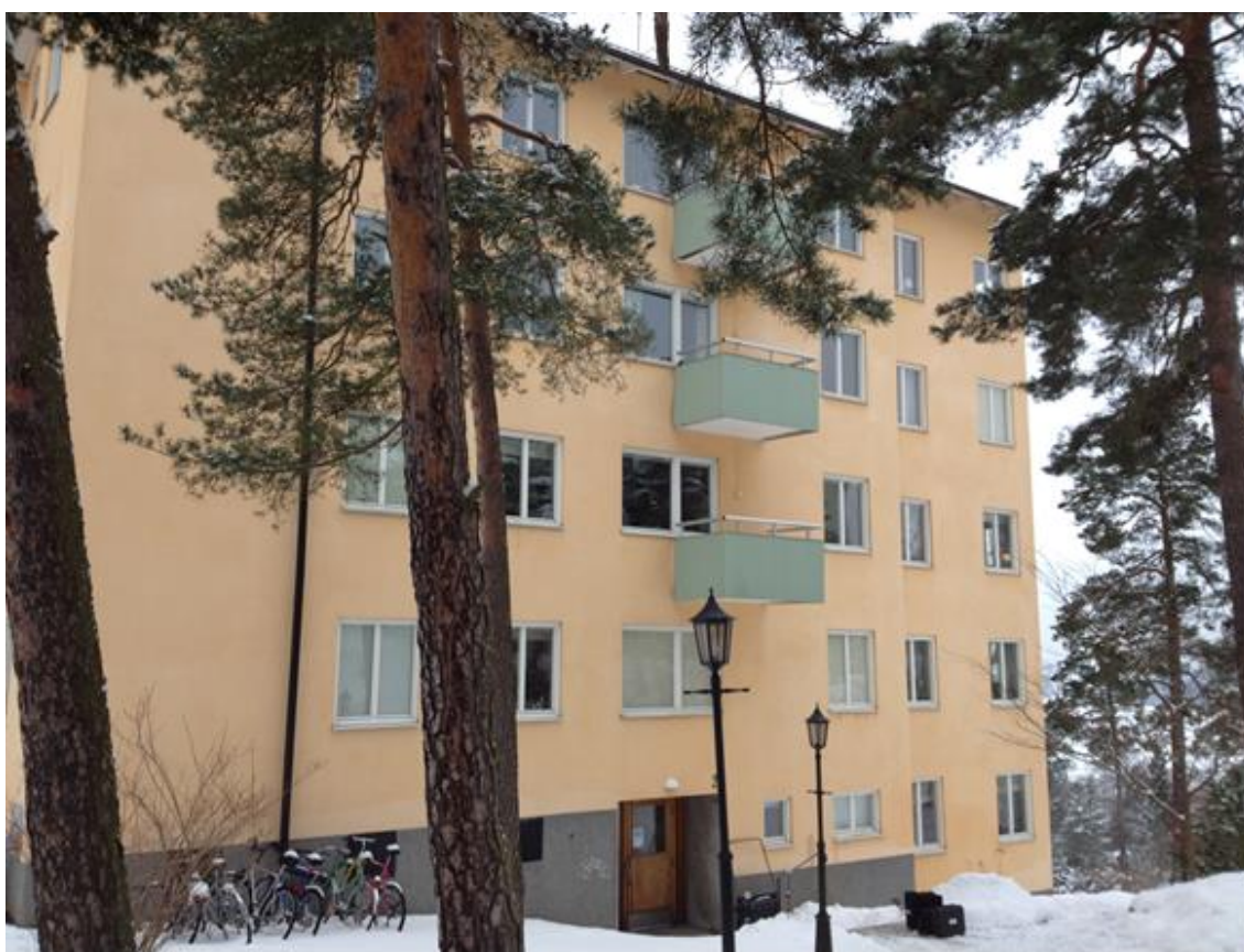
Figur 1 Fasad före åtgärd.
