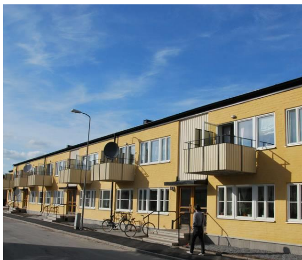
Figur 14. Fasader som visar utseendet efter ombyggnad av del av kvarteret Kvarngärdet i Uppsala. Fasaden är i allt väsentligt oförändrad tack vare invändig isolering. Foto: Uppsalahem
