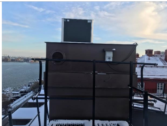
Clean-Air standardmodul. En av de brandavlastande ventilerna syns på frontens vänstersida.
