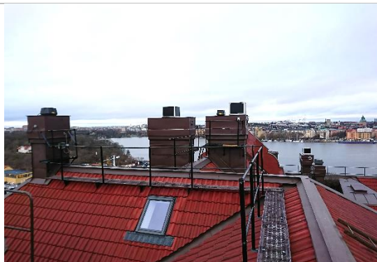
Clean-Air standardmodul. En av de brandavlastande ventilerna syns på frontens vänstersida.
