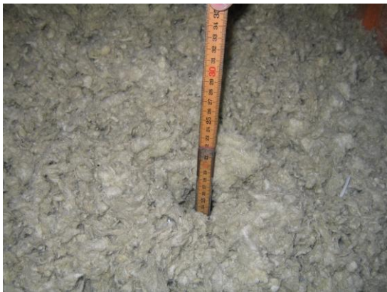
Bild 1 Nya vindsisoleringen Styrbords- och Babordsgatan
