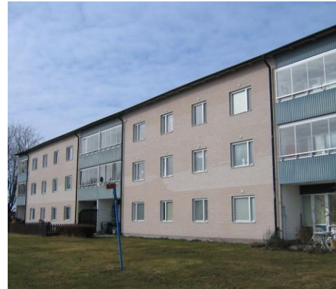
Bild 10 Östra Raden, inglasade balkonger
