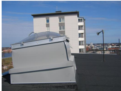
Bild 16 Brandlucka på övre taket, Babords- och Styrbordsgatan
