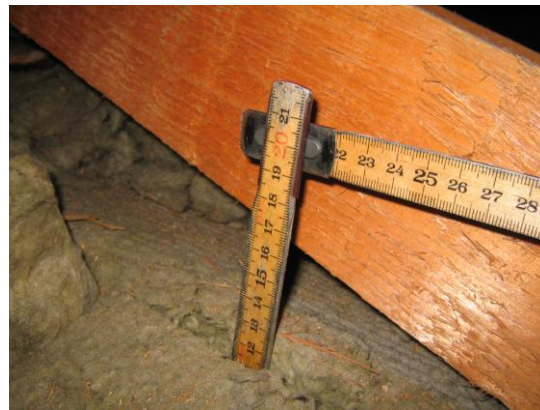
Bild 2 Vindsisolering på Ö:a Raden
