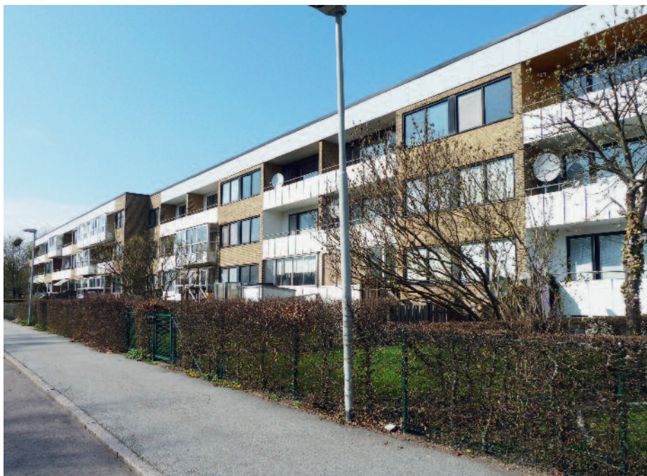
Figur 1: Projektets utgångspunkt, ett typiskt hus från rekordåren, tre våningsplan och sex trapphus, 36 lägenheter och källare.
