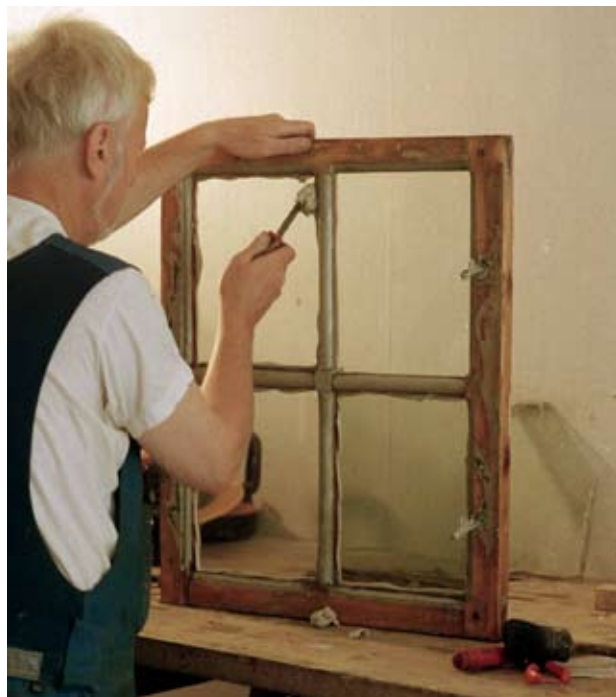
Äldre fönster är ofta av så bra virke att ommålning och omkittning räcker. I enstaka fall kan rötade bottenstycken behöva bytas ut.
