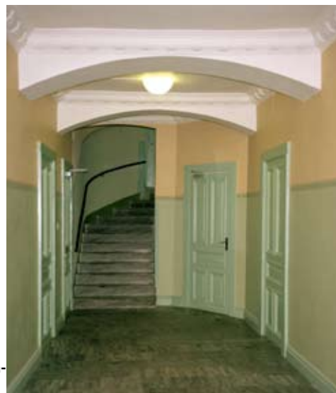
Trapphus på Västerlånggatan 75.
