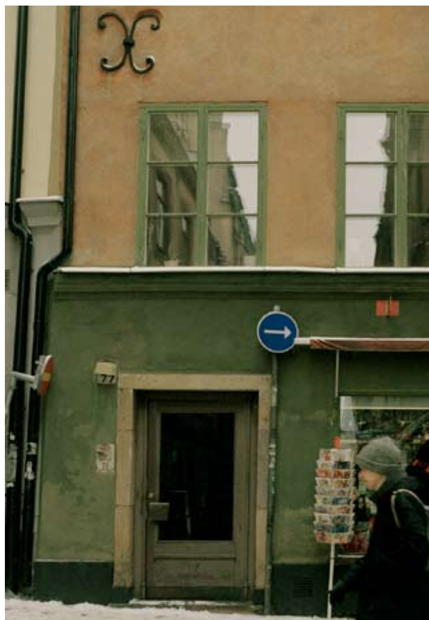
Stupröret till höger är av modernare utformning. När det behöver bytas ut väljs hellre utförandet till vänster.
