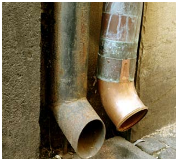
Stupröret till höger är av modernare utformning. När det behöver bytas ut väljs hellre utförandet till vänster.
