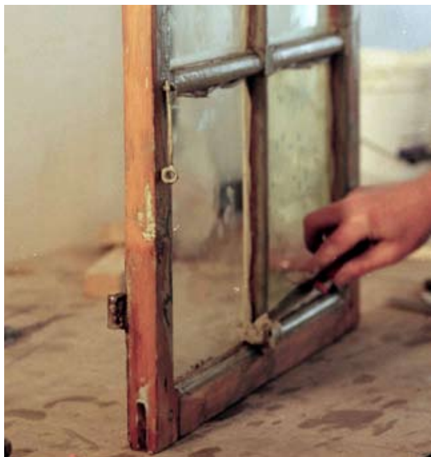
Vid omkittning av fönster används alltid linoljekitt.
