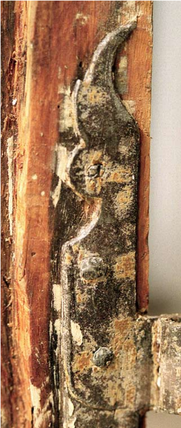
Äldre fönsterbeslag som bevaras och renoveras.
