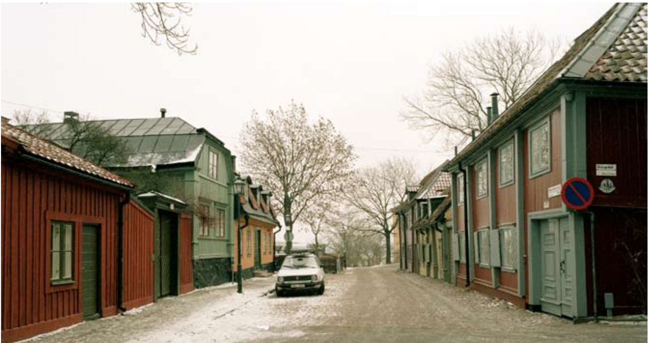
Inpanelad timmerstomme med linoljade fasader. Husen är uppförda efter Katarinabranden 1723 och är ombyggda flera gånger, senast på 1970-talet. Mäster Mikaels Gata 6–10 och 7–11.
