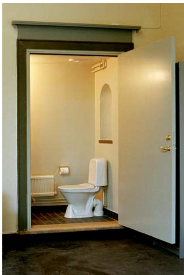
Så långt möjligt sparas tidigare detaljer. Här har en ny toalett tillskapats i en tidigare passage.
