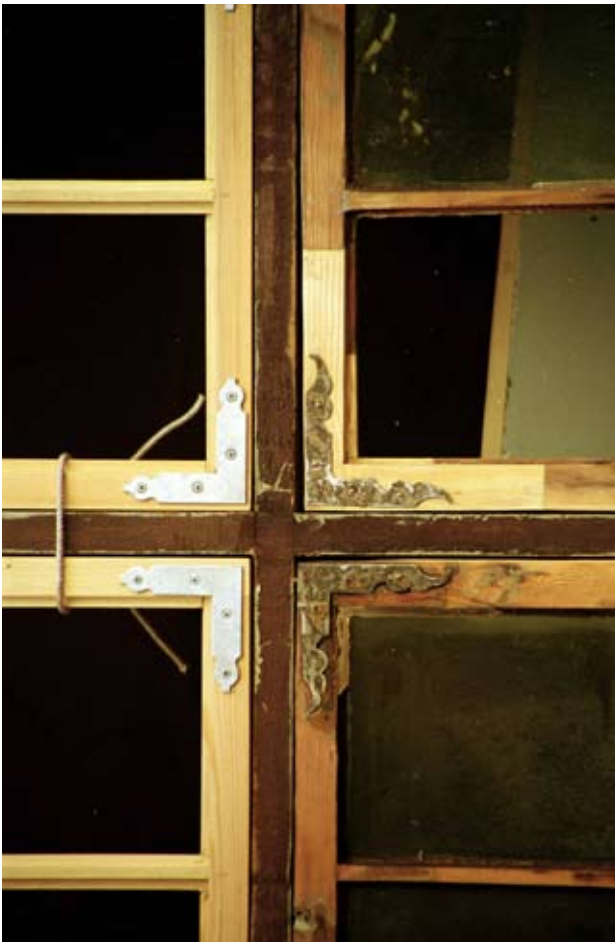
När fönster renoveras byts endast skadade partier ut.
