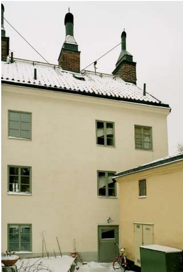
Färgsättning av Stadsholmens byggnader görs utifrån antikvariska och stadsbildsmässiga bedömningar.
