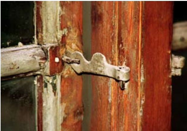
Äldre stängningsanordningar bevaras där de finns kvar.
