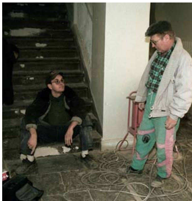
Vid renovering används traditionella material och metoder. Många detaljfrågor måste lösas direkt på plats.
