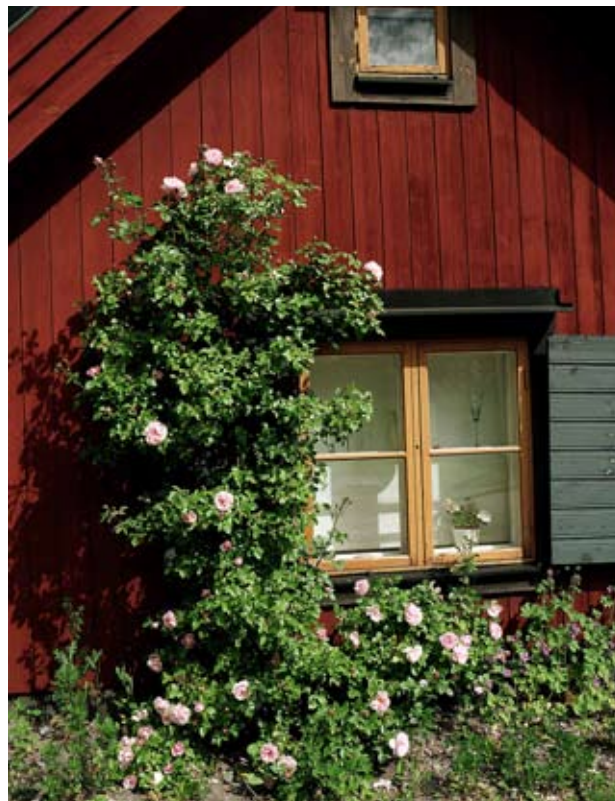
Klängväxter ska klättra/fästas på nät eller spaljé, inte direkt på fasad.
