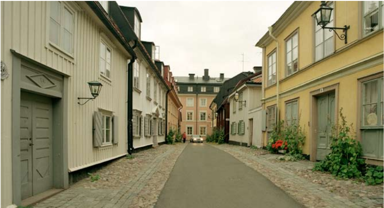
Många trähus har blandade konstruktioner. Exempelvis kan bottenvåningen vara knuttimrad medan den övre våningen, kanske tillbyggd på 1800-talet, har en regelstomme. Breda Gatan i Djurgårdsstaden.
