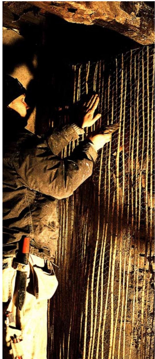
Nätning med kycklingnät och vass som underlag för putsning.
