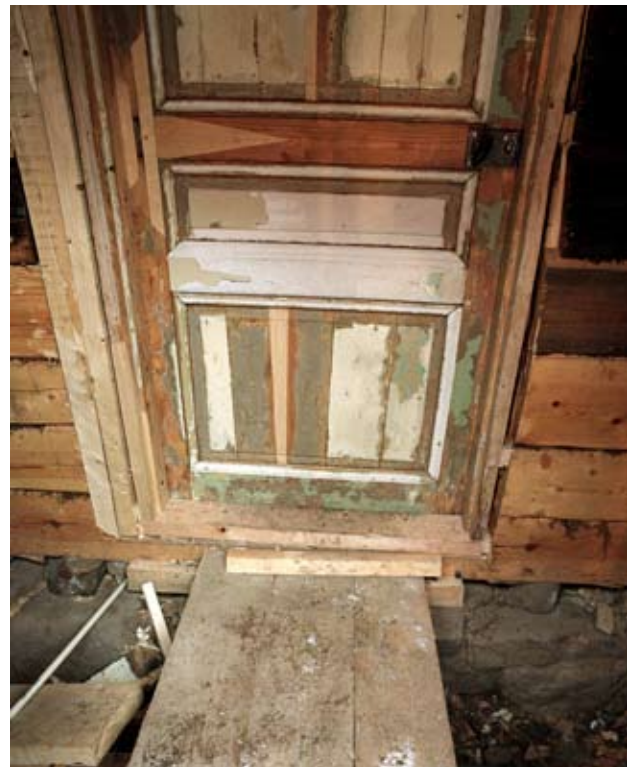
Äldre dörr med nya ilagningar.
