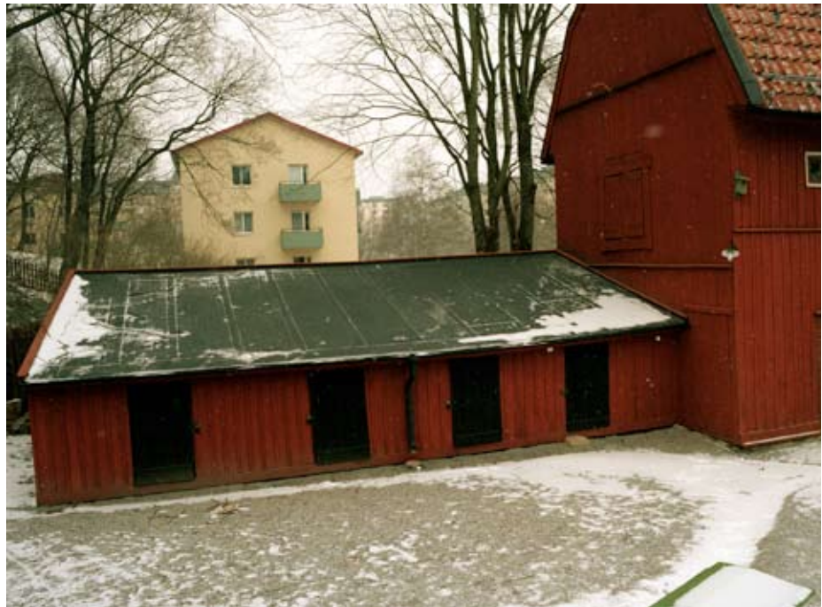
Äldre förråd och vedbodar, ombyggda 1998–99. De används idag som lägenhetsförråd. Gaveliusgatan 5.
