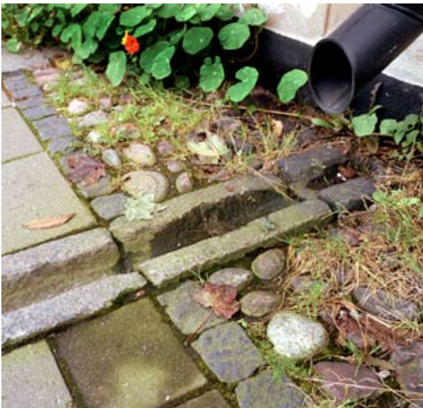
Ränndalar behöver hållas rena så att inte ett stopp eller en ansamling av löv eller liknande gör att vatten kan tränga in i fasadmuren.
