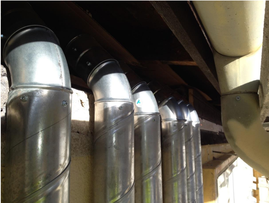
Tilluftskanalers övergång till vindsbjälklag innan isolering med nätmatta.
