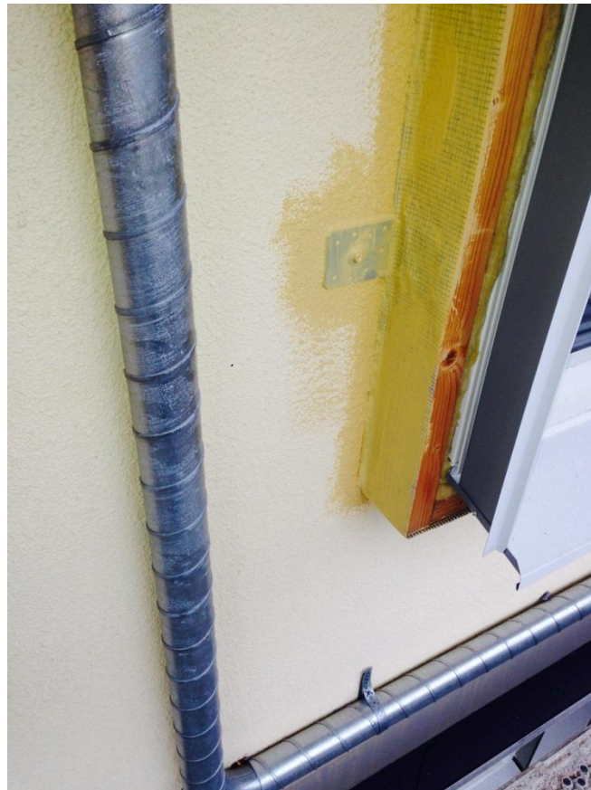
Monterad tilluftskanal och nytt utflyttat fönster.
