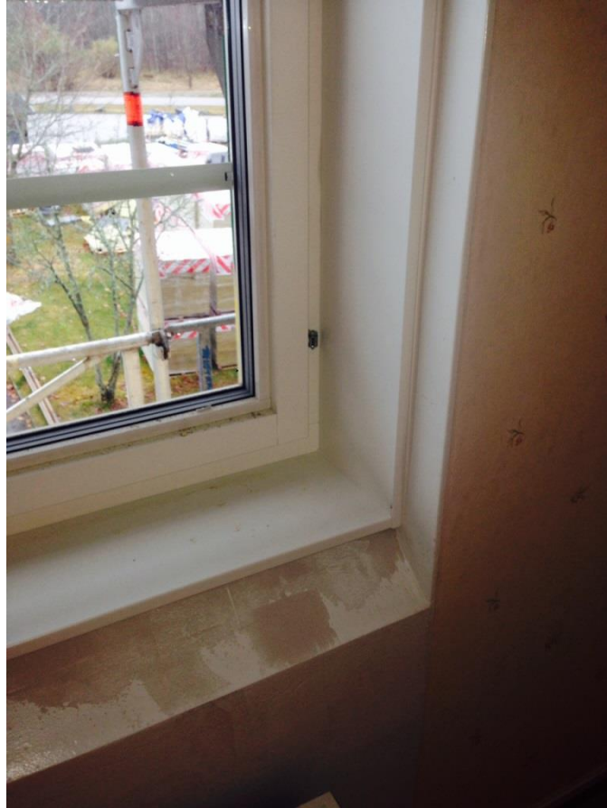
Inklädd fönstersmyg vid utflyttat fönster.
