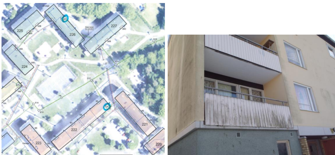
Figur 1 Fasad före åtgärd och situationsplan över etapp 2-området på Lagrådsgatan, som omfattar åtta byggnader fördelat på två undercentraler, placerade på Lagrådsgatan 6 respektive 24.
