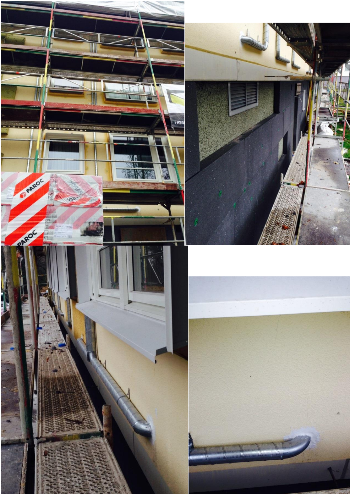
Figur 4 Bilder på kanaldragning från byggtiden.
