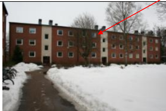
Figure 1a. Sandviksvägen 38 B. Entrance.
