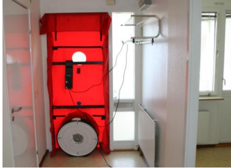
Minneapolis blower door för att upprätthålla -50 Pa i lägenheten och för mätning av läckluftflöde.
