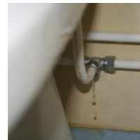
Fördelningslinga (samt vattenläckage) i badrum.
