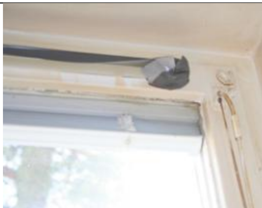
Bild 3a. Läckage vid fönster, mellan båge och karm.
