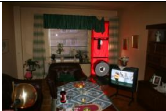
Bild 2a. Blower Door monterad i öppning för balkongdörr.
