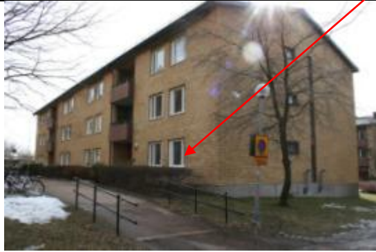
Bild 1a. Rosenbergsgatan 24 A. Entrésida.
