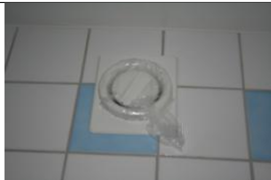
Bild 2b. Vid täthetsprovningen tätades frånluftsdon och uteluftsdon provisoriskt.
