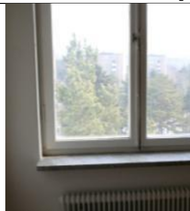
Bild 6b. Otäthet mellan fönsterbågar samt mellan bågar och karm.
