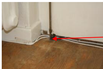
Bild 2a och 2b. Läckluftflöden genom klimatskal lokaliserades och dokumenterades med värmekamera, Flir modell i50.
