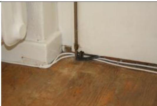
Bild 2a. Läckage vid balkongdörr, mellan båg och dörrkarm/tröskel.
