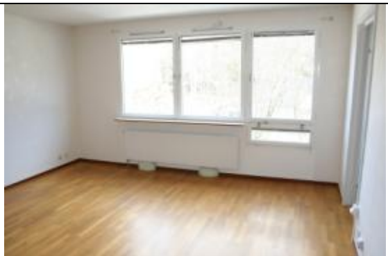
Bild 9a. Ursprungligt FT-system med tilluftsdon ("Elefantfot") i golv har ersatts av F-system med uteluftsdon (Biobe-ventil) i fönsterkarm. Det gamla tilluftssystemet är dock inte proppat varför överluftföring mellan lägenheter kan förekomma. Vid denna täthetsprovning uppmättes överluftföring av ca 33 l/s, ( 9+9+15=33 l/s).
