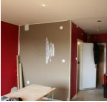
Bild 8a. Lägenheterna på Saltvägen 10 har, förutom i badrum, även frånluftsdon i vardagsrum.
