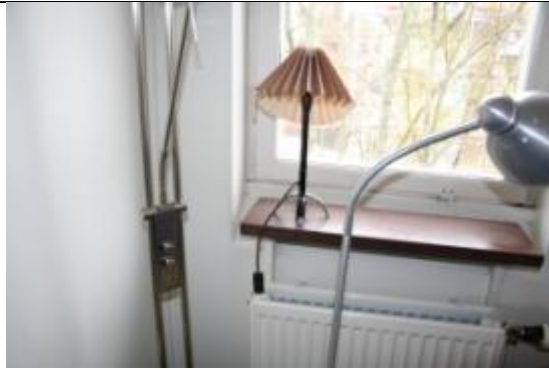
Bild 5a. Läckage mellan fönsterbåge och karm.
