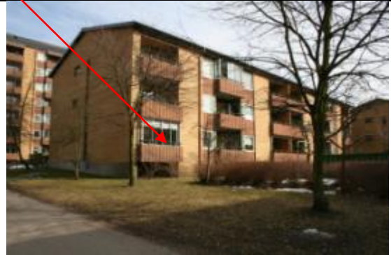
Bild 1b. Rosenbergsgatan 24 A. Balkongsida.
