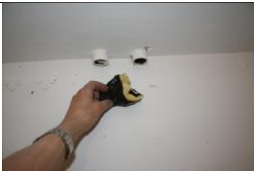
Bild 7a. Rören var provisoriskt tätade med instoppad glasull.
