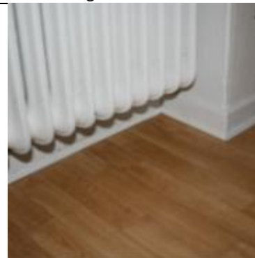
Bild. Sovrum, otäthet mellan golvsoclel och golv.
