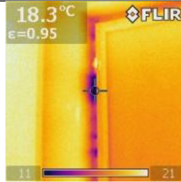
Bild 4b. Kök, läckage mellan fönsterbåge och karm.
