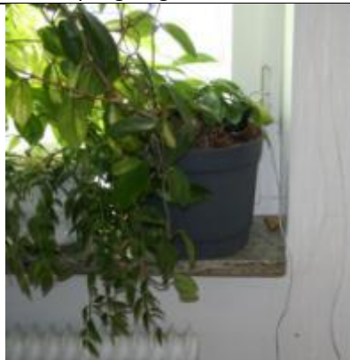
Bild 2a. Läckage vid fönster (mellan båg och karm)
