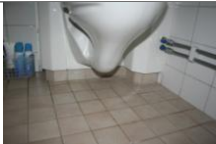
Bild. Det största läckaget konstaterades vara vid inklädnad för rör-schakt. Troligen är brandtätning mellan rör och bjälklag otät varför luft kan spridas mellan lägenheter. Hyresgäst upplever problem med luktöverföring från cigaretttrök i angränsande lägenhet.
