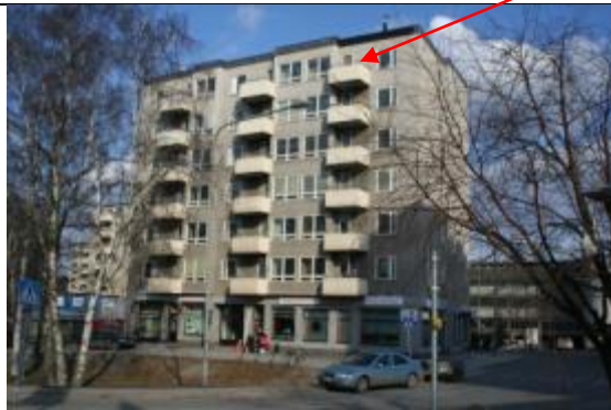
Bild 1a. Kommunavägen 20, Entrésida mot väster.
