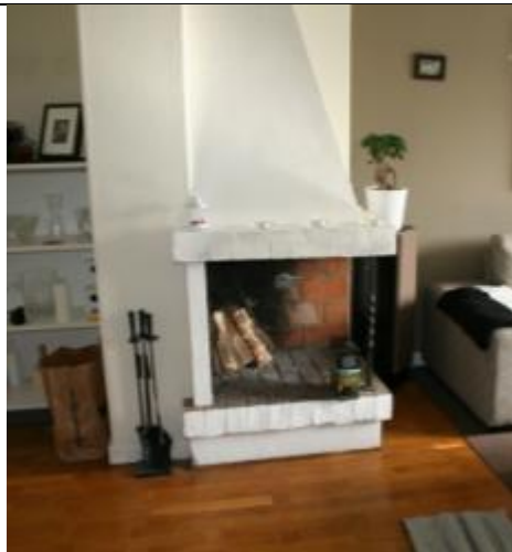
Bild 5a. Täthetsprovning utfördes dels vid otätad och dels vid otätad öppen spis, rökspjället var helt stängt i bägge fallen.
