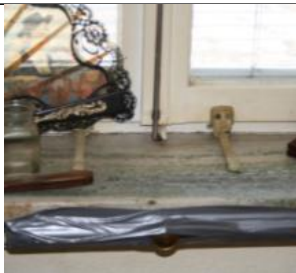
Bild 3a. Läckage vid fönster, mellan båge och karm.
