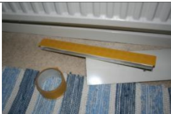
Bild 2a. Uteluftsdon bakom radiator tätades provisoriskt under provningen.
