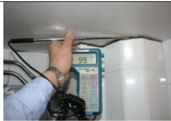
Bild. I springa till rörschakt uppmättes lufthastigheter kring 1 m/s som antagligen beror på inläckande luft från angränsande lägenhet. Undertrycket i lägenheten konstanthölls vid -50 Pa vid denna mätning. (Stambyte ägde rum ca 2005)
