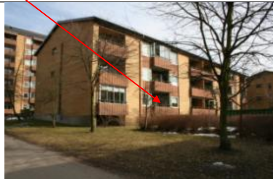
Bild1 b. Rosenbergsgatan 24 A. Balkongsida.
