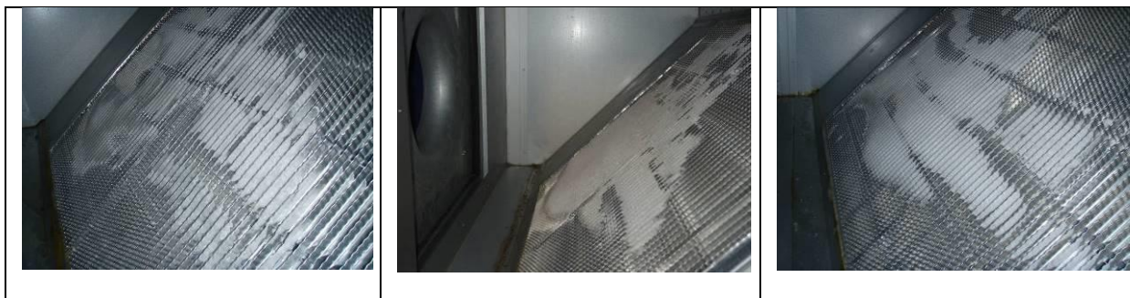
Figur 12: Isbildning på värmeväxlarens avluftssida för aggregat 9, 10 och 11 den 29 december.
