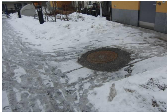
Bild 2. Brunn till kulverrör
