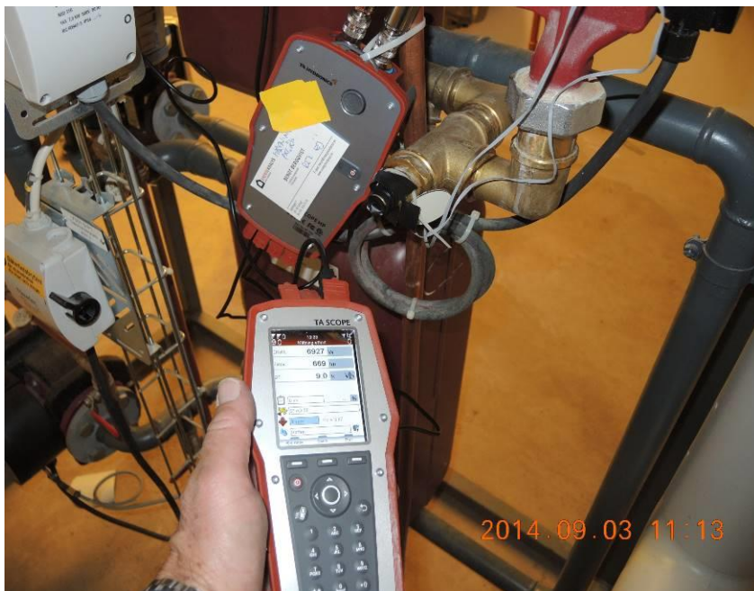
Bild 2.1. Momentanmätning med TA Scope indikerar VVC-förluster kring ca 7 kW motsvarande ca 7 \cdot 8760 = 60 MWh/år motsvarande ca 60000/2400 = 25 kWh/m 2 ,år. (STAD 20, öppen 3,0 varv, 6,9 kW, 669 l/h, dT=9°C.
