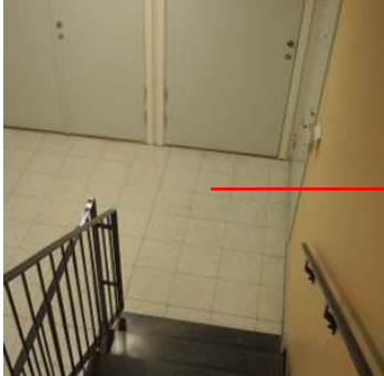
Bild 1. Värmeavgivning från VV och VVC i bjälklag.
