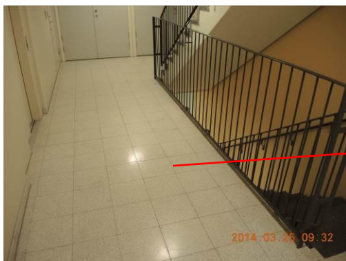
Bild 11. Värmeavgivning från VV och VVC i bjälklag.
