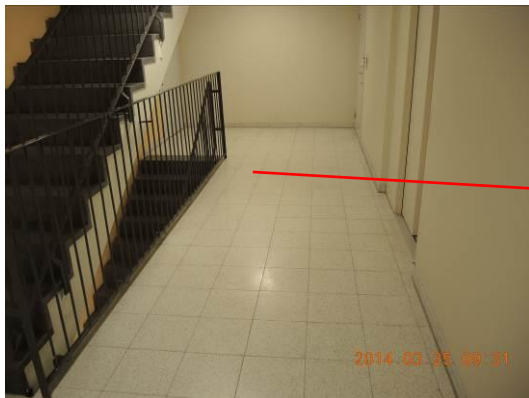
Bild 9. Värmeavgivning från VV och VVC i bjälklag.
