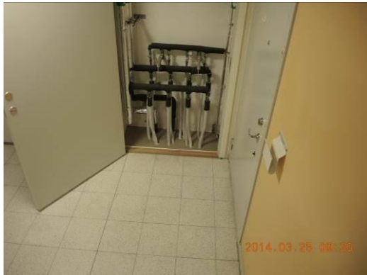
Bild 7. Våningsfördelare till 4 lägenheter.
