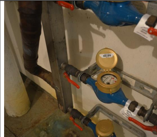
Bild 2.1. Nya vattenmätare installerades under sommaren 2014.
