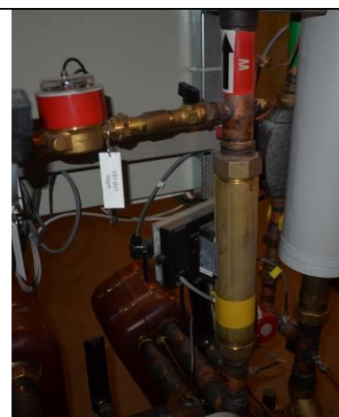
Bild 2.6. Värmemängdsmätare varmvatten inkl VVC.
