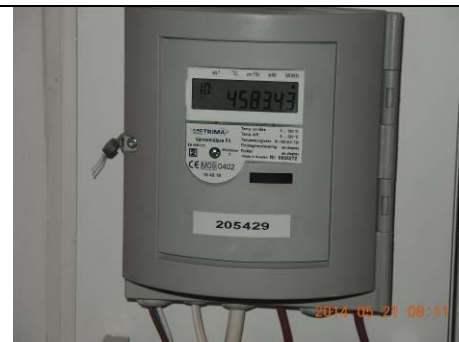
Bild 2.4. Fjärrvärmemätare
