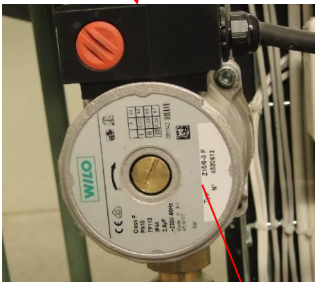
Bild 3. VVC-pump har märkeffekt 44-87 W.
