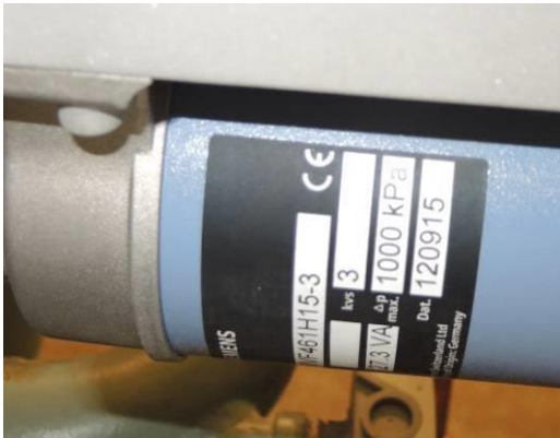
Bild 7. Styrventil, VV har kvs=3,0.
