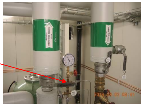
Bild 10. Loggningar utfördes med avstängningsventil, VS21 dels i läge öppen och dels i läge stängd.
