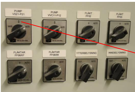
Bild 9. Loggningar utfördes med pump VS21-P21 dels i läge Auto och dels i läge 0.
