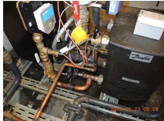
Bild 8. Loggning av temperaturer på VV och VVC.
