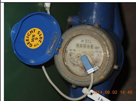
Bild 5. Flödesmätare som mäter varmvattenanvändning.
