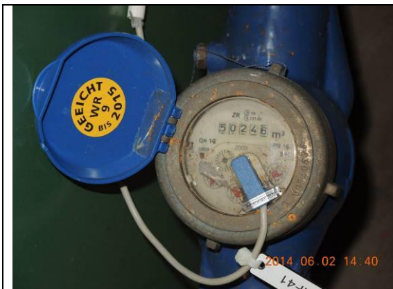
Bild 2.3. Flödesmätare som mäter varmvattenanvändning.
