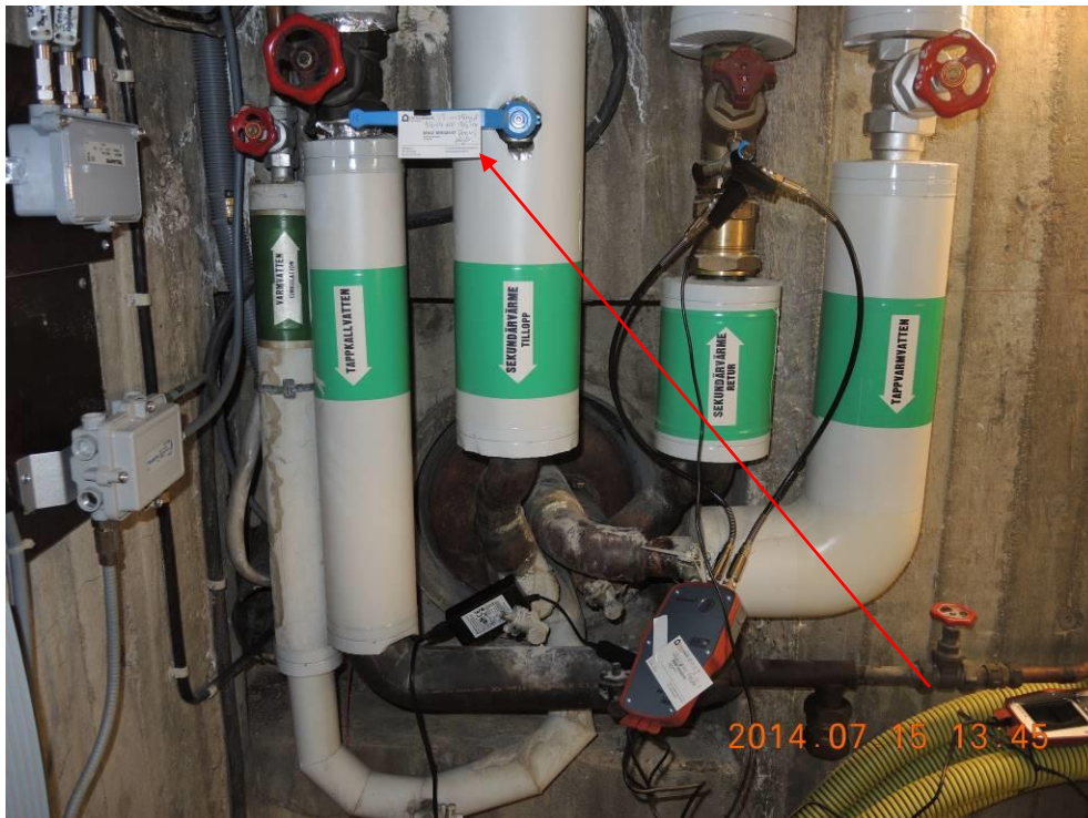
Bild 2.10. Quattro-kulvert vid VS-pump. Prov med stängd ventil.
