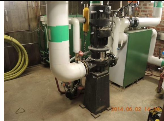
Bild 7. Cirkulationspump i värmekrets VS1.
