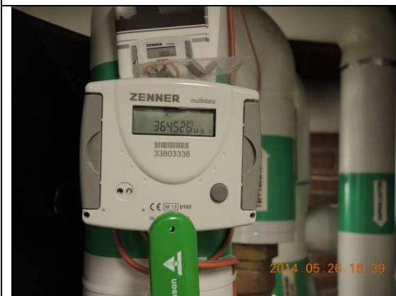
Bild 3. Värmemängdsmätare, som mäter värmeförluster i VVC-krets.
