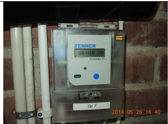
Bild 2.2. Fjärrvärmemätare
