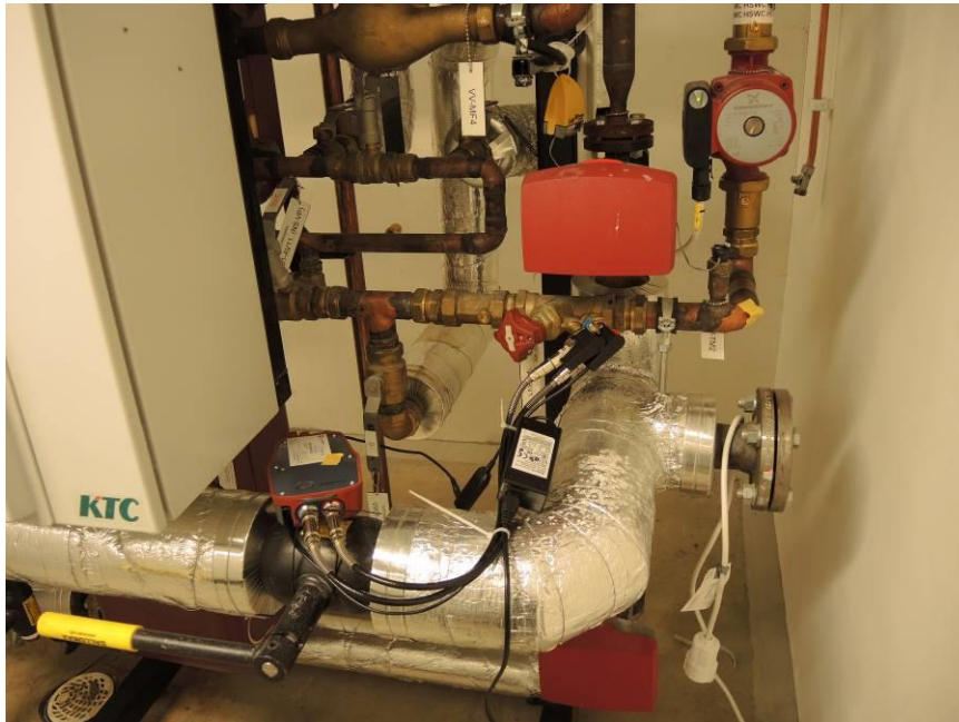
Bild 2.1. Loggning av värmeförlusteffekt med TA Scope. VVC-pumpens märkeffekt uppgår till 135-220 W.
