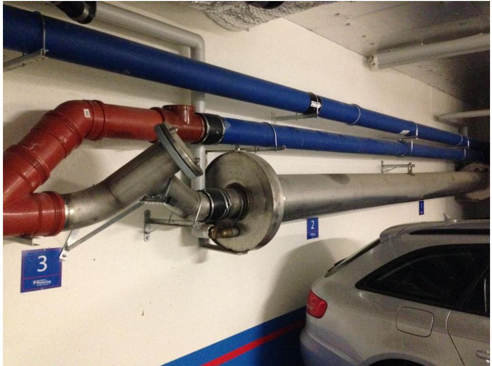
Figur 7.2 Liggande rörvärmeväxlare i Gubbängen (foto Anders Nykvist).
