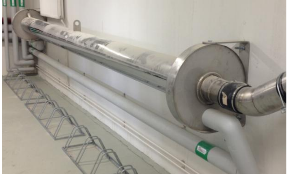
Figur 6.1 Liggande rörvärmväxlare (Foto: Anders Nykvist).
