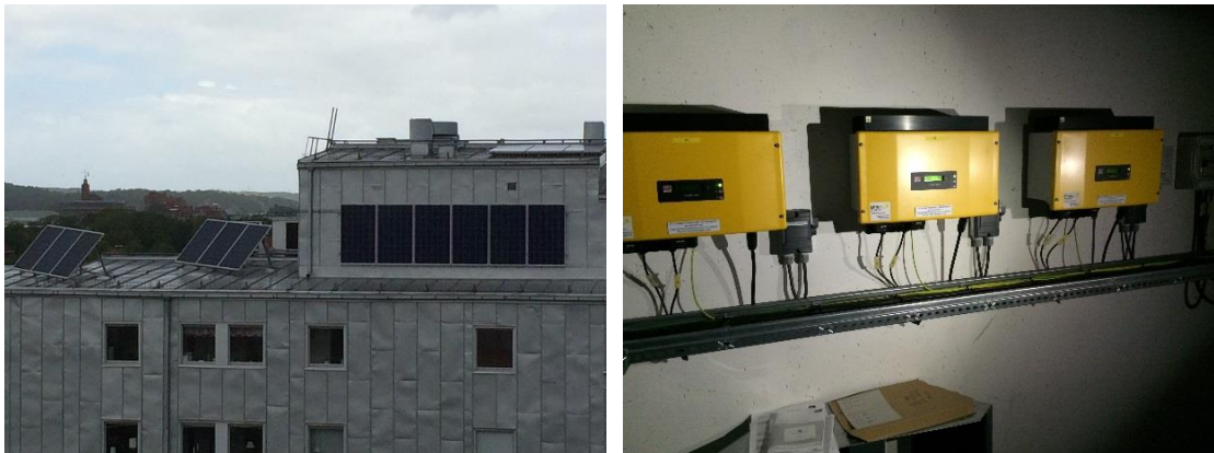
Bild 3: Några av Bostadsbolagets solpaneler & växelriktare i Göteborg
