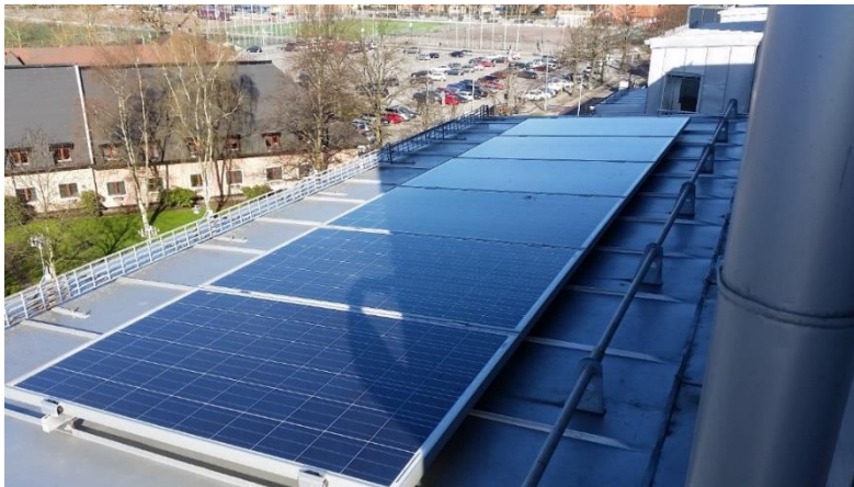
Bild 4: Skuggning av nästan horisontella solpaneler i sydväst under morgontimmar, vilket reducerade dessa panelers elproduktion.
