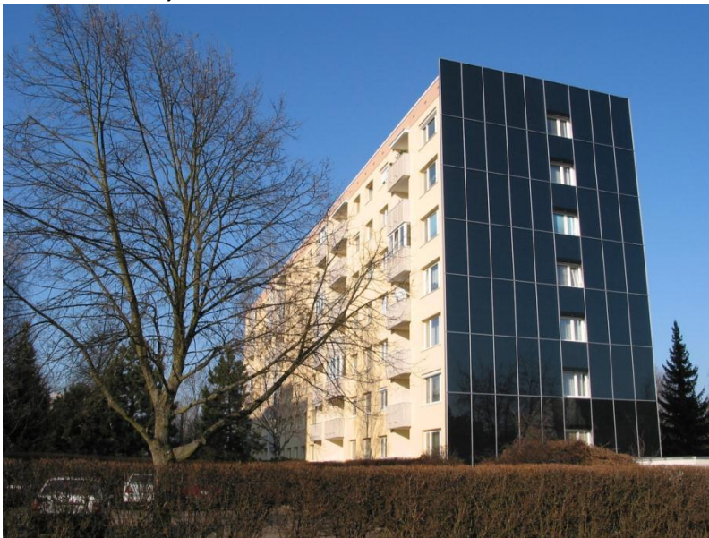
Fasadanläggning på flerbostadshus.
