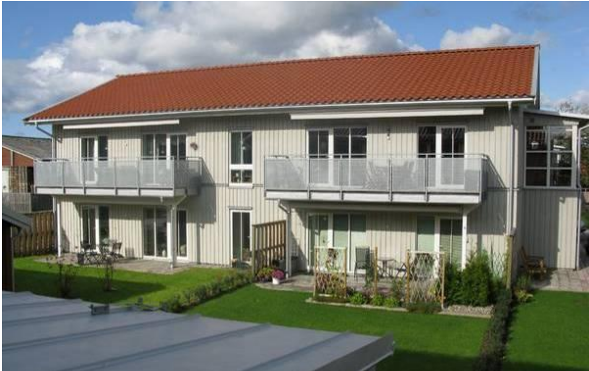
Solfångare installerade för uppvärmning av varmvatten.
