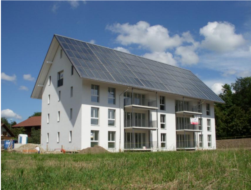
Takanläggning på flerbostadshus.
