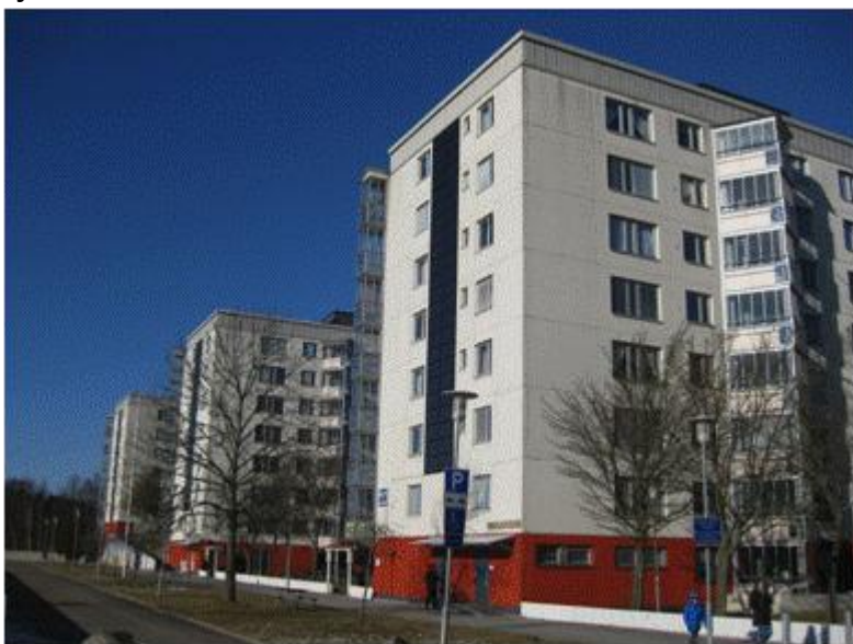
Figur 7.2 Fasadintegrerade solceller i Hjällbo
