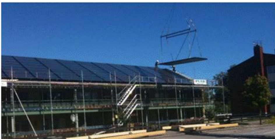
Figur 5.3 Takreovering med solfångare i Vislanda
