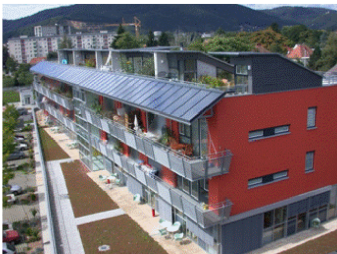
Figur 5.10 Solfångarna till uppgift att både fungera som solavskärmning och att tillhandahålla varmvatten och energi till uppvärmning.
