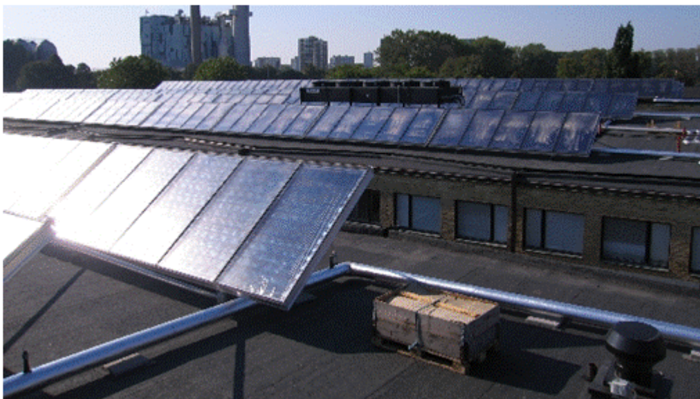
Figur 5.5 Solfångare installerade på platta tak i Heleneholm.
