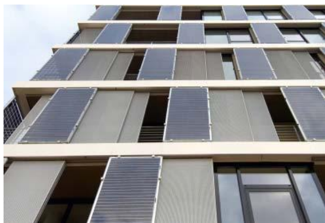
Figur 7.14 Exempel på kristallina solceller som kan användas som solavskärmning.
