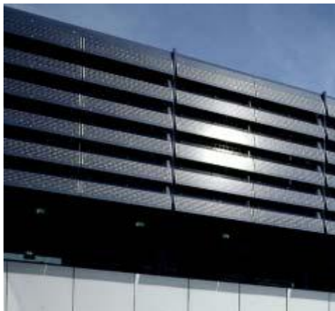
Figur 7.14 Exempel på kristallina solceller som kan användas som solavskärmning.
