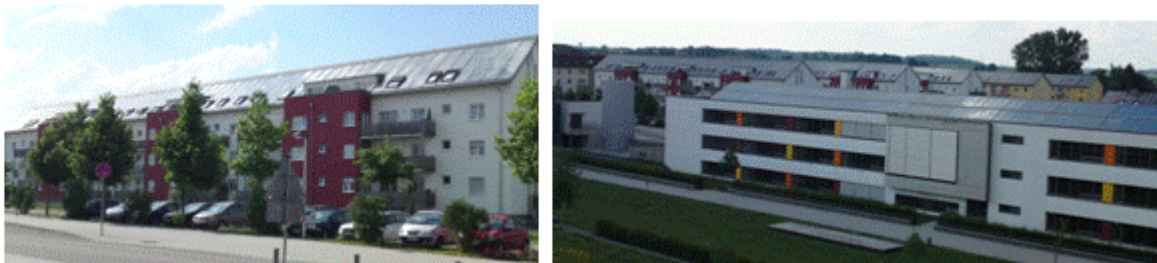
Figur 5.9 Stor solvärmeanläggning på nya hus i Tyskland
