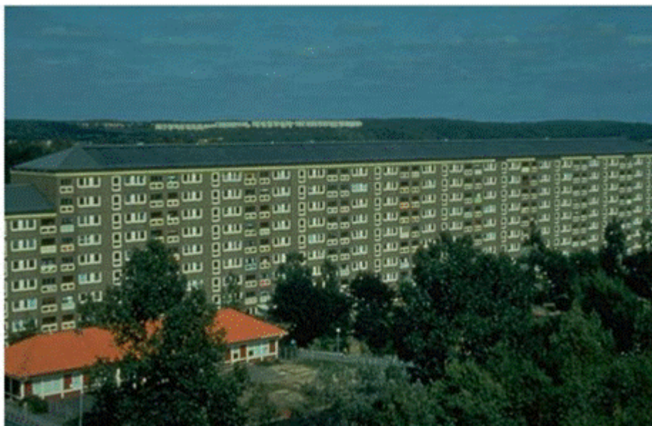
Figur 5.1 Ett av höghusen i Hammarkullen där solvärme installerades 1985
