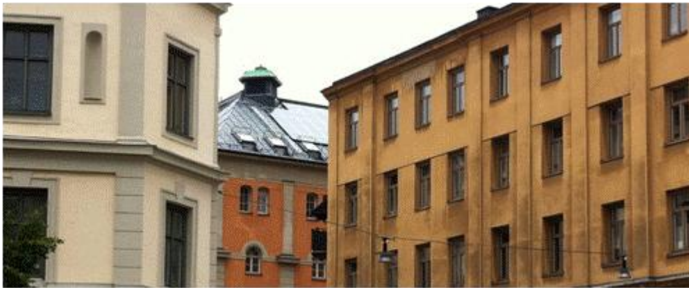
Figur 7.3 Solceller på befintligt flerbostadshus i Stockholm
