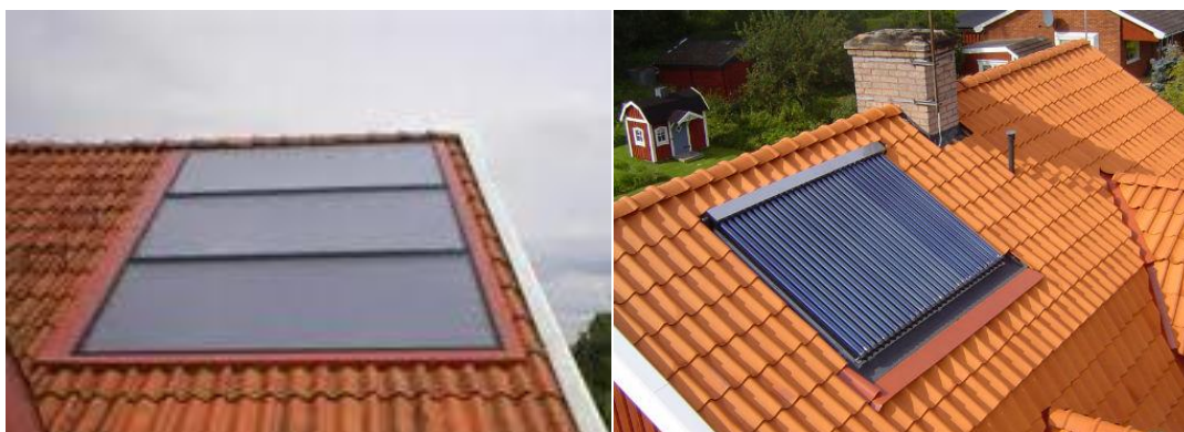
Figur 4.1 Plan solfångare respektive vakuumrörsolfångare
