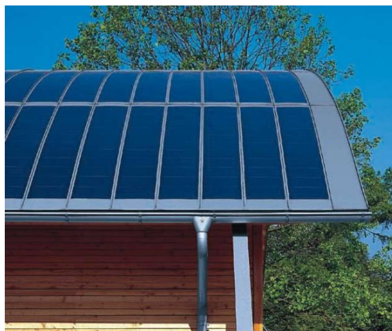
Figur 7.13 Exempel på tunnfilmssolceller som kan användas som tak. Fungerar även på böjda tak.
