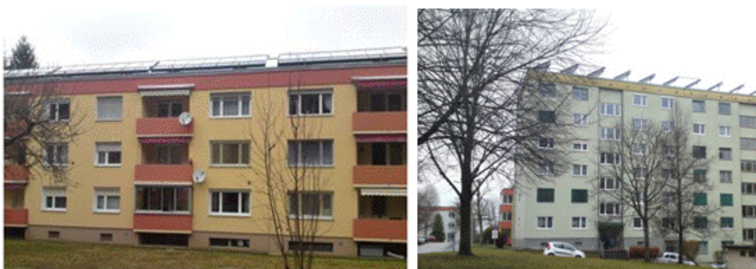
Figur 5.6 I Graz monterades solfångare på taken i ett befintligt flerbostadshusområde 2004.
