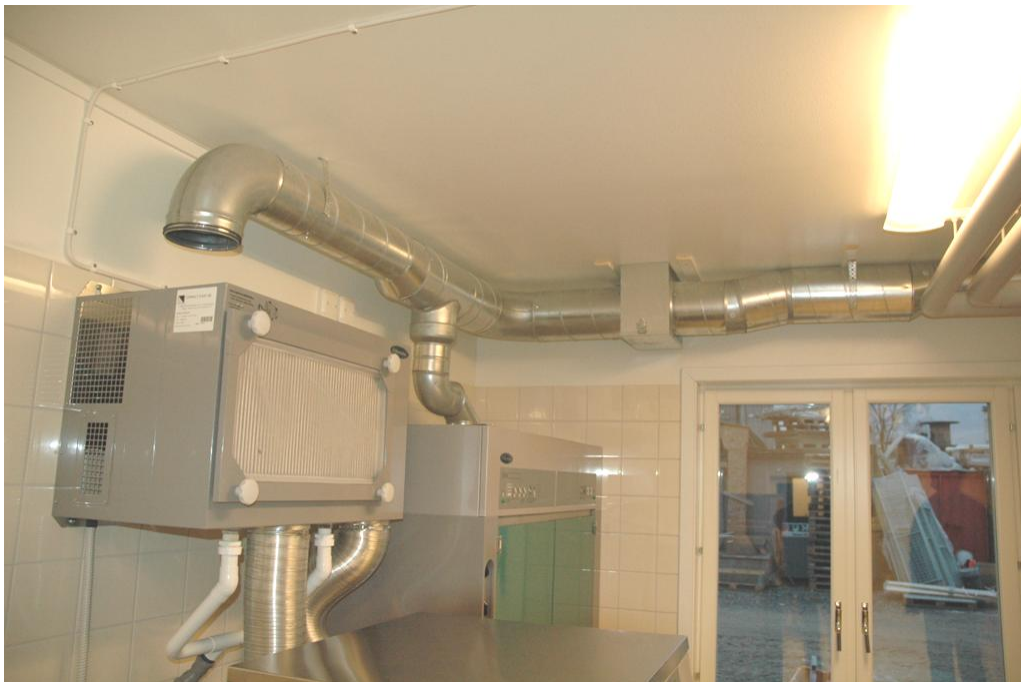
Figur 20 All denna kanaldragnig behövs inte om torkningen sker med värmepumpsteknik Foto Roland Johansson
