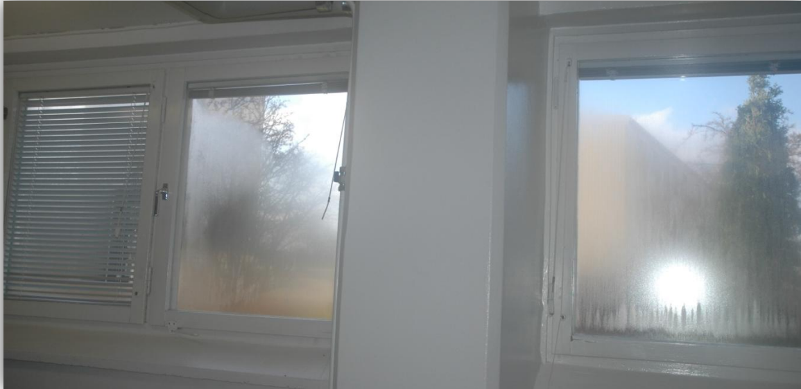
Figur 16 Kondenserad vattenånga i varm luft i en tvättstuga. Vid en av testkörningarna i tävlingen kunde följande konstateras "Tvätten var helt torr när tiden gått ut. Jag mätte även kondensen från båda maskinerna som stod jämte varandra, resultatet blev cirka 8 cl vatten från alla fem körningarna, däremot blev lokalen full av fukt så alla fönster blev täckta med fukt." Så här ser det inte ut om maskinen har kondensationseffektivitet A. Vid en A-klassning kommer allt vatten ut via kondensslangen och inte till rummet, som ses på bilden. Bilden är inte tagen i samband med testningen. Foto Roland Johansson, HSB.
