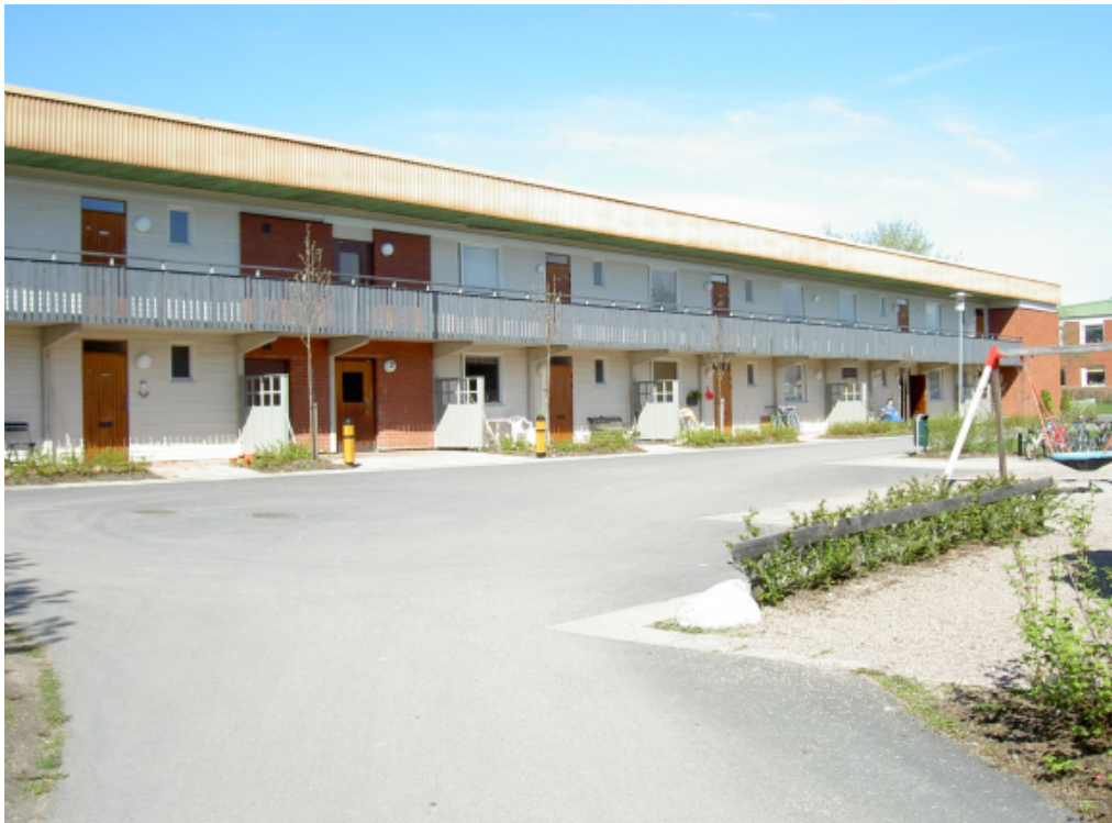
Figur 1 Byggnaden på Norrbackavägen 21 före åtgärd.
