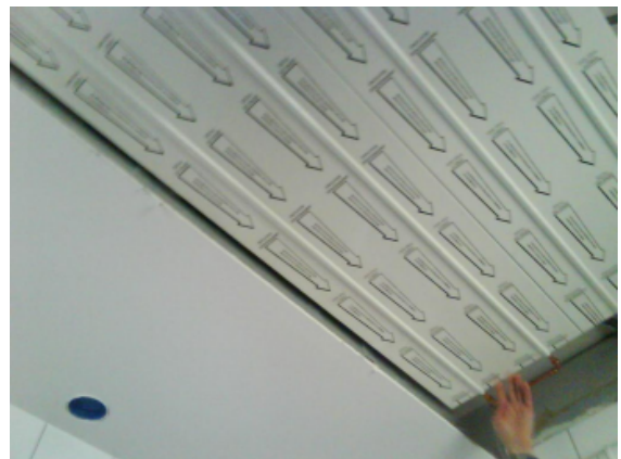
Figur 5 Ny takvärme i badrum
