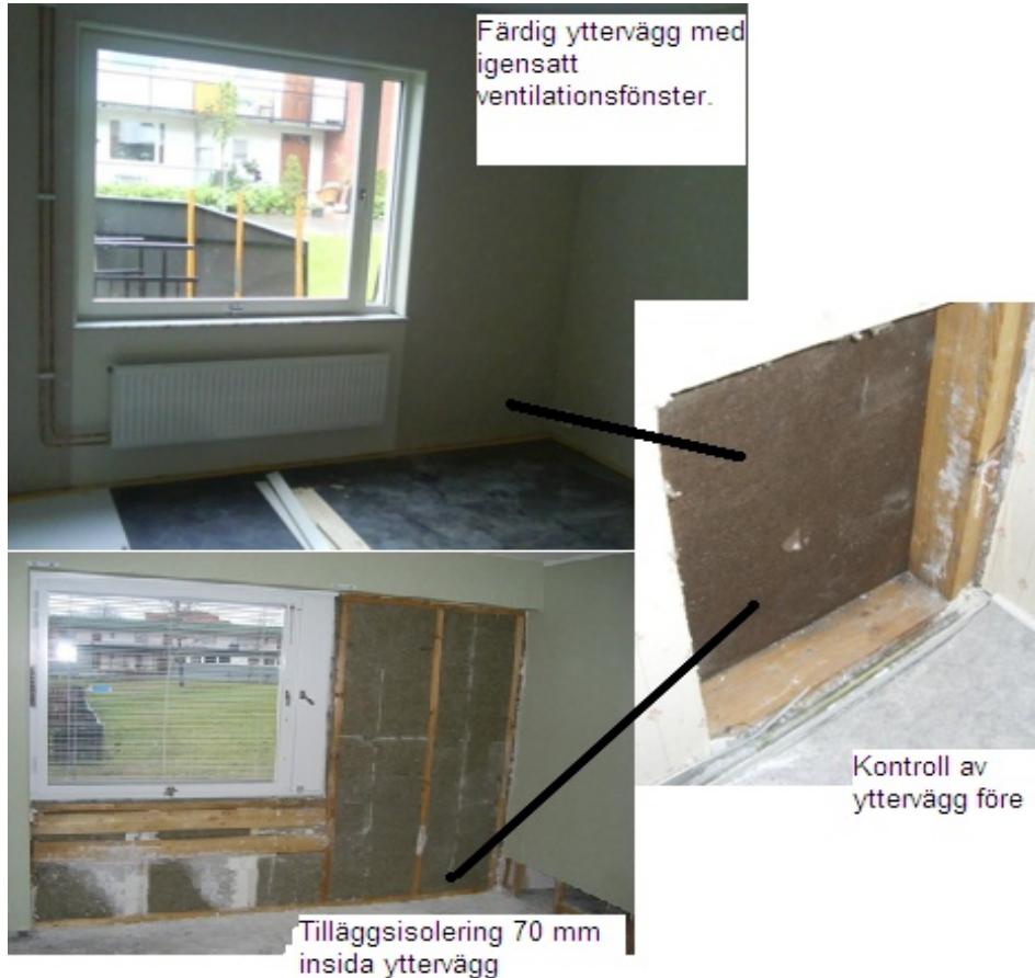
Figur 4 Invändigt isolering av ytterväggen, borttagning av befintlig gipsskiva och plastfilm.
