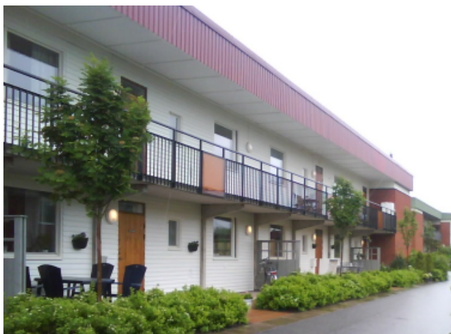
Norrbackavägen 21 efter ombyggnad.
