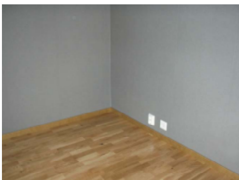
Luftläckning i vägghörn mot innervägg (Vid tidigare inspektion noterades att plastfolien i yttreväggen ej går obruten förbi aktuell innervägg. Detta är anledningen till observerad luftläckning.)
