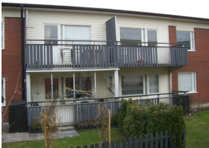
Norrbackavägen 21 före ombyggnad
