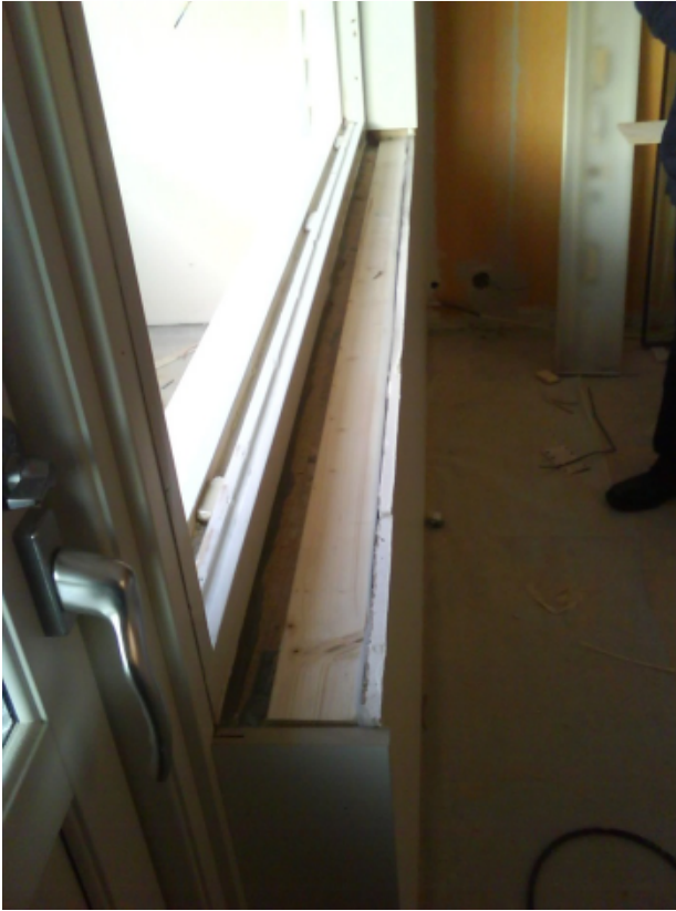
Tilläggsisolering insida yttervägg.
