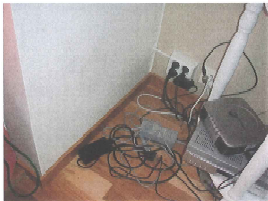
Luftläckning vid golvvinkel.
