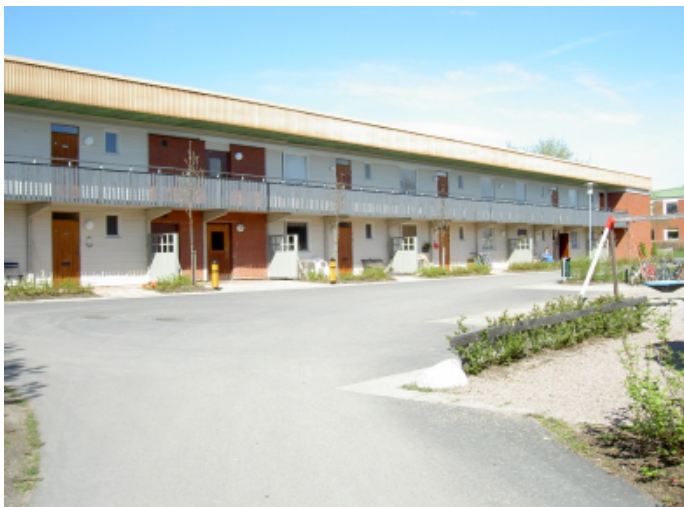
Norrbackavägen 21 före ombyggnad
