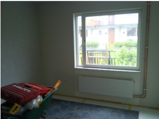
Norrbackavägen 23 med FTX, fixerat vädringsfönster.
