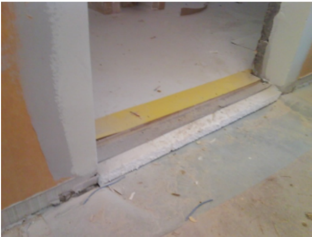
Tilläggsisolering golv i bottenvåning.
