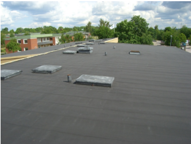
Tak före åtgärd
