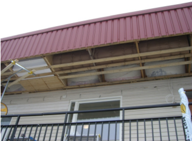
Isolering av kulvertstråk i 21:an.
