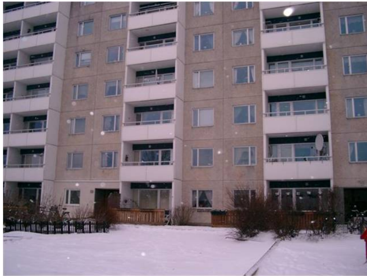
Babordsgatan före åtgärd.
