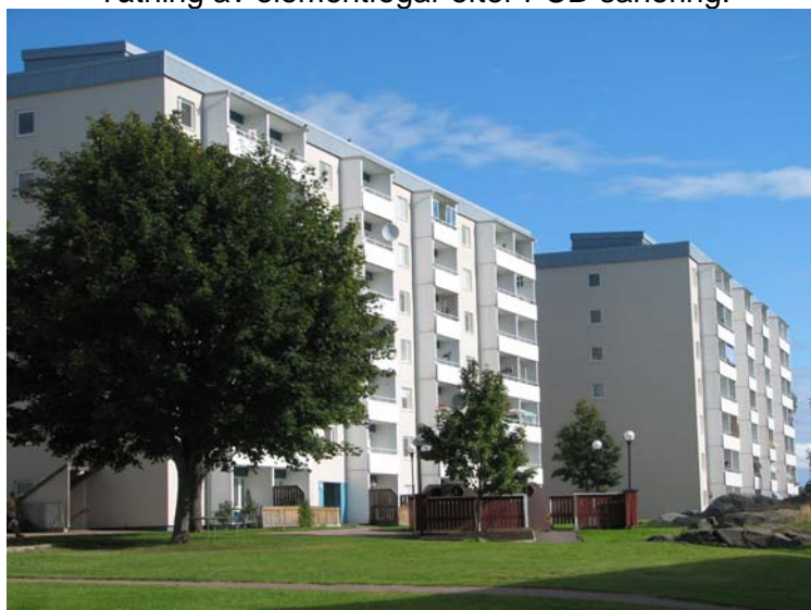
Babordsgatan efter åtgärd.
