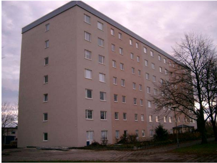
Babordsgatan efter åtgärd.
