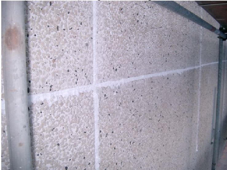
Tätning av elementfogar efter PCB-sanering.
