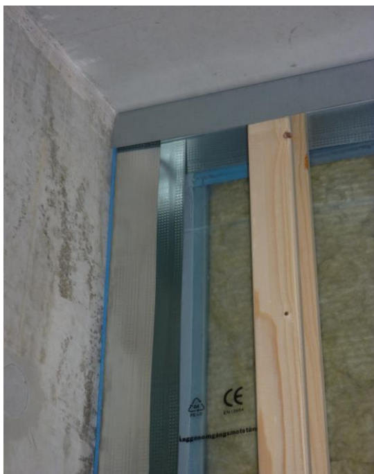
Utfackningsvägg mot bärande innervägg. Tätning runt stålpelare i yttervägg.
