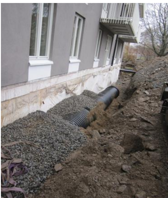
Markkanal för tilluft.
