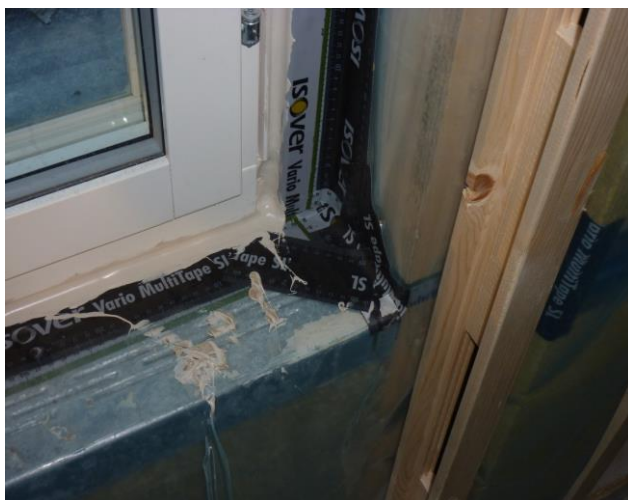
Komplettering med fogmassa.
