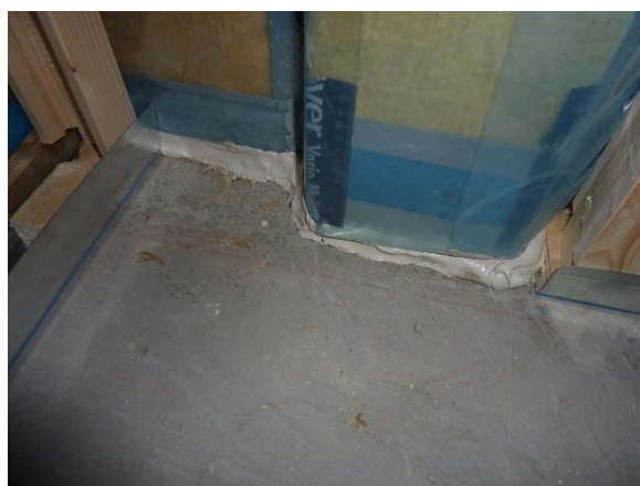
Utfackningsvägg mot bärande innervägg. Tätning runt stålpelare i yttervägg.
