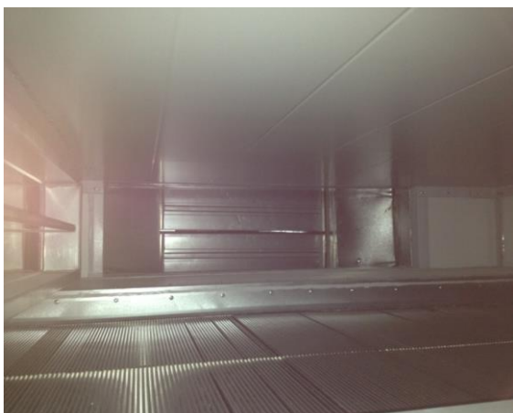
Tätning av otätt spjäll vid tryckprovning.
