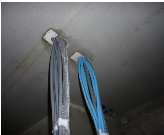
Installationsgenomföringar i bjälklag.
