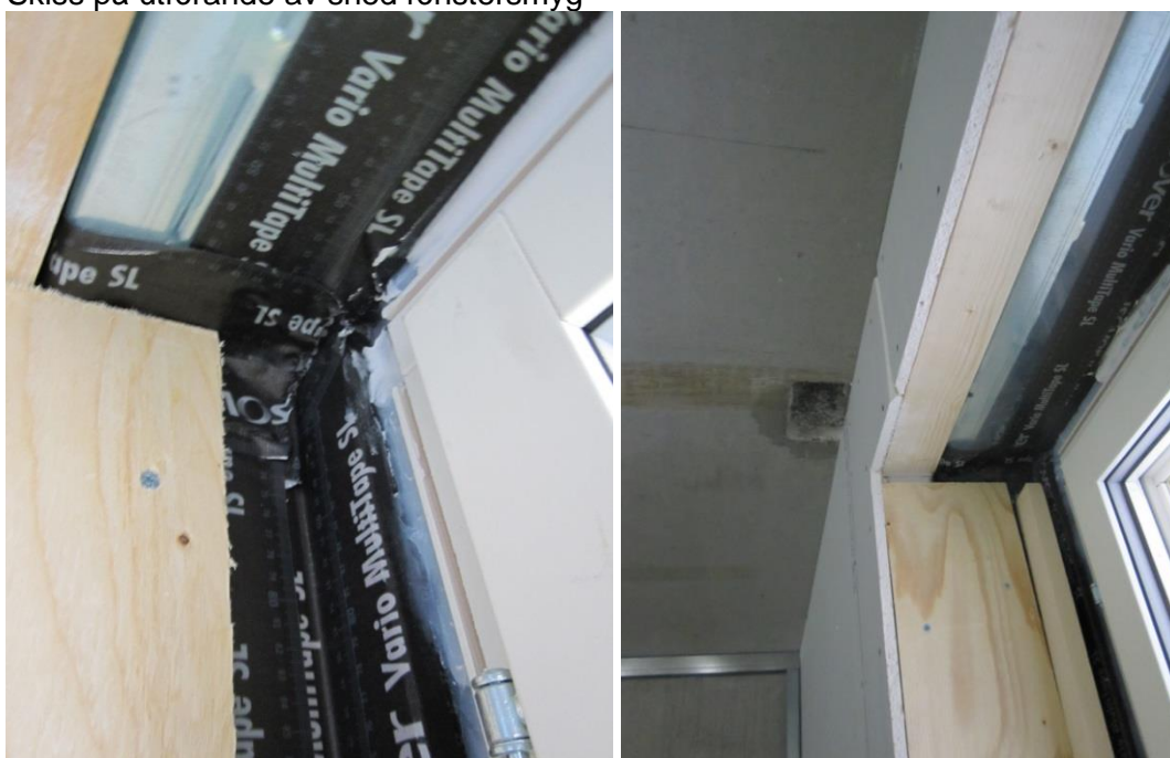
Tätning i fönstersmyg.
