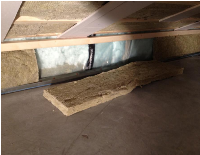
Tätning vid takfot mot varmt utrymme.
