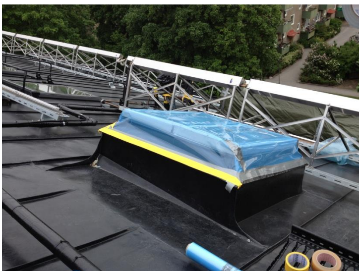
Tätning av ännu ej installerad taklucka vid tryckprovning.
