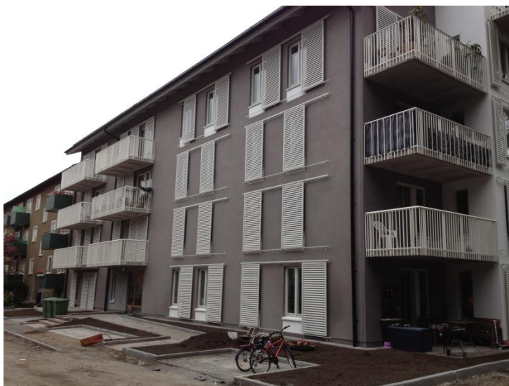
Figur 1 Fasad med fönsterluckor för solsydd.
