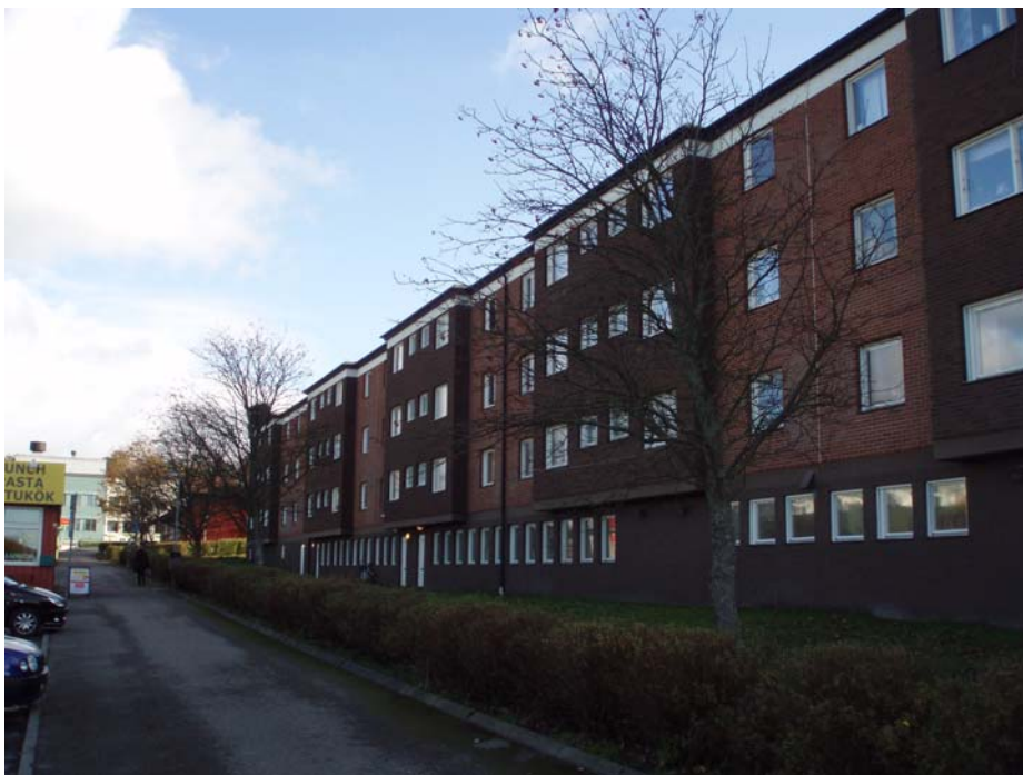
Figur 1. Del av byggnaden på Rosengatan 1-23 före åtgärd.
