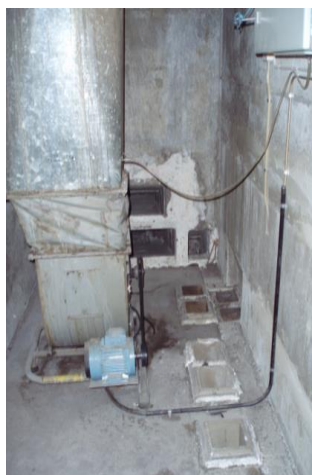
Gammal fläkt i sugkammare (dock ny motor).
