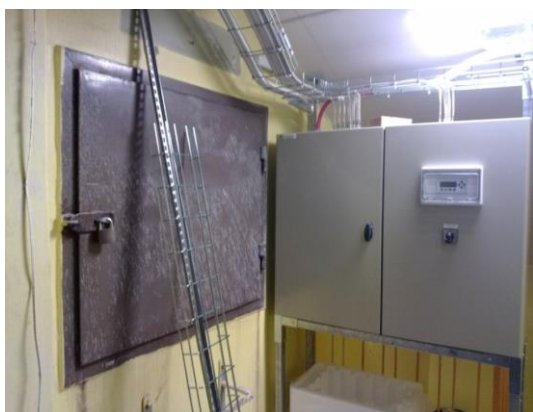
Nytt aggregat med hjälpfläkt för forcering samt apparatskåp och "filterbyteutrymme".
