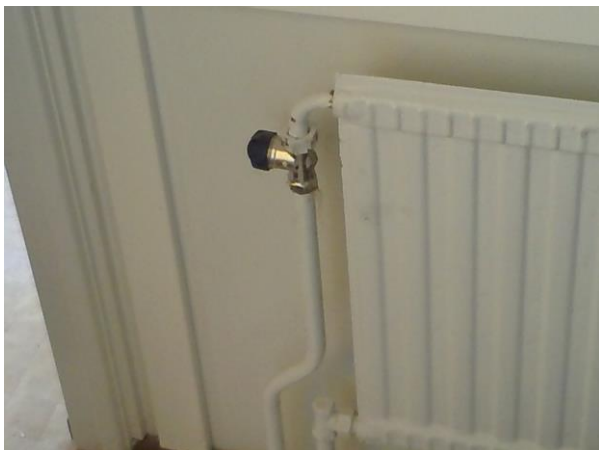
Ny termostatventil utan känslkropp.
