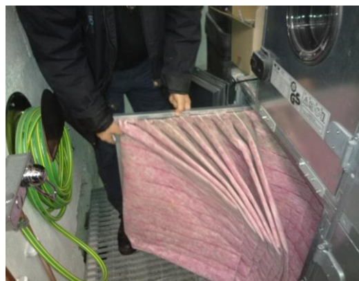
Nytt aggregat med hjälpfläkt för forcering samt apparatskåp och "filterbyteutrymme".
