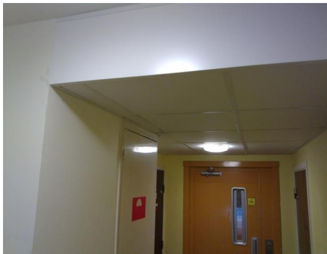
Sänkt undertak i tapphus.
