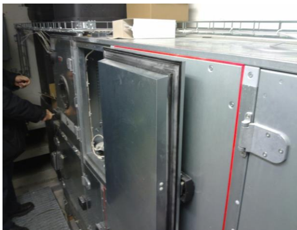
Gammal fläkt i sugkammare (dock ny motor).
