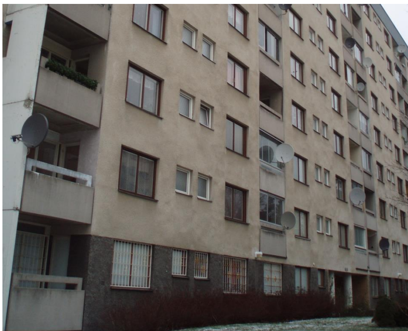
Figur 1 Balkongfasad för Stora sällskapets väg 46-52 före åtgärd.
