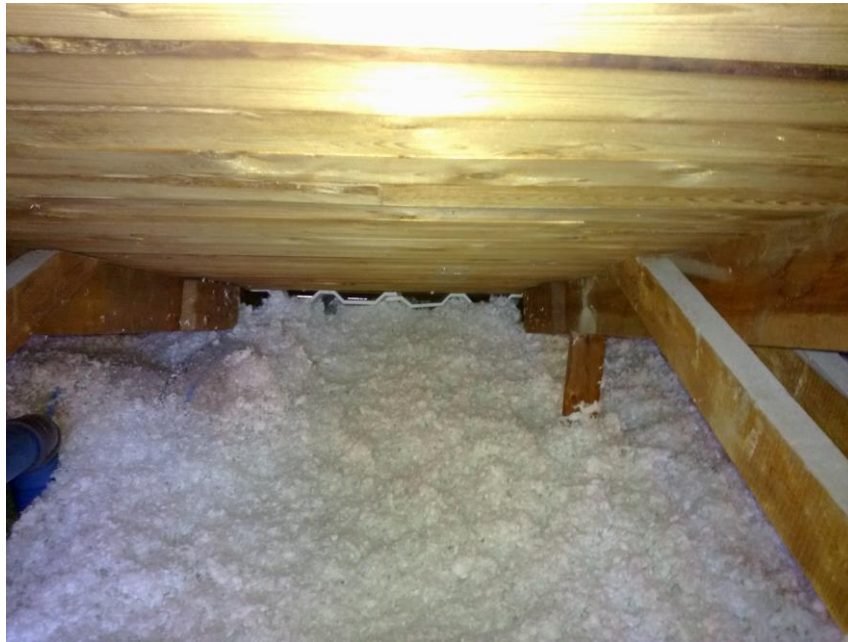
Figur 5 Ny vindsisolering och luftspaltsskivor vid takfot.
