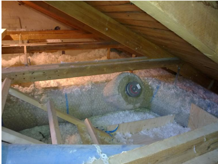
Ventilationsrör i ny vindsisolering (ej färdigställt).
