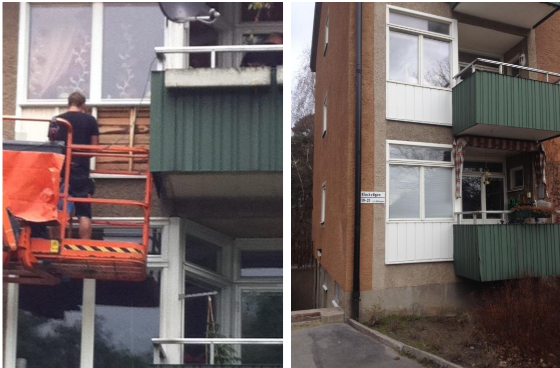
Isolering och renovering av fönster och bröstningspartier (under och efter).
