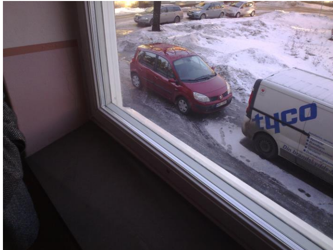
Ny isolerruta i fönsterinnerbåge.
