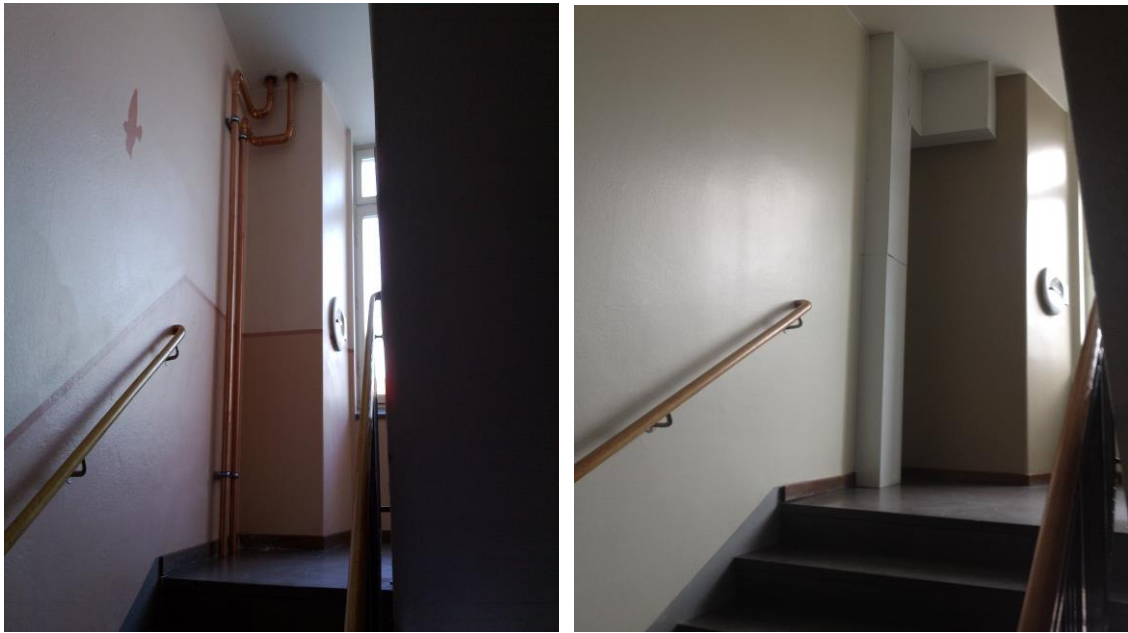
Brinerör dragna i trapphuset före och efter plåtinklädnad.
