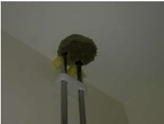
Genomföring för nya radiatorstammar i kök.
