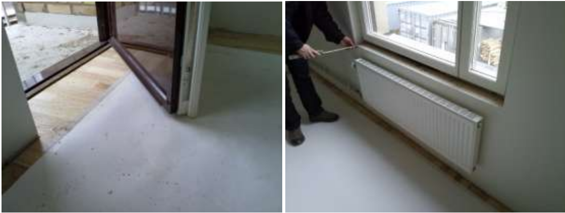
Låg höjd för balkongtröskel. Tilläggsisolering av radiatornisch i sovrums.
