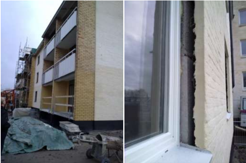
Gavel med konverterade butiker. Nytt tegel vid balkonger samt nytt slammat fasadtegel runt nya fönster, där den gamla fasadstenen togs bort.
