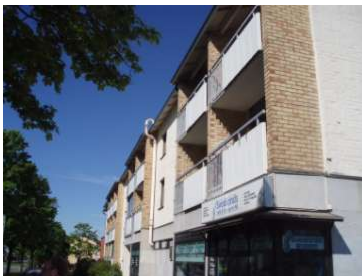
Figur 1 Johannesbäcksgatan 48 A-B före åtgärd.
