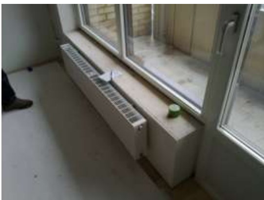
Invändig isolering av balkongvägg och ny balkongdörr.
