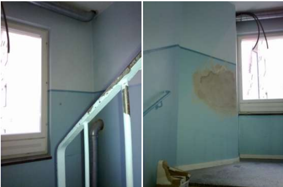
Kanaldragning för tilluft i trapphus och gammalt sopnedkast före inklädnad.
