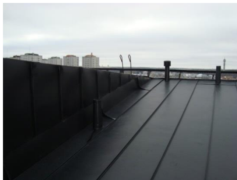
Nytt plåttak och plåtarbeten.
