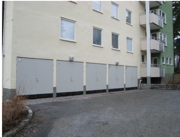
5st garageportar som är uppvärmda. ~ 75 m 2 .
