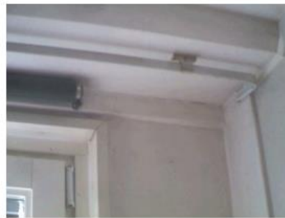
Punkt 1: Luftläckage vid sprickor i skarv mellan vägg och tak
