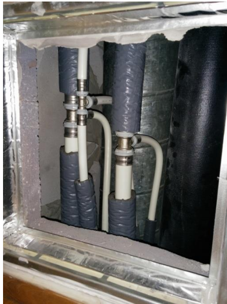
Inspektionslucka till schakt där VVC-krets är dragen
