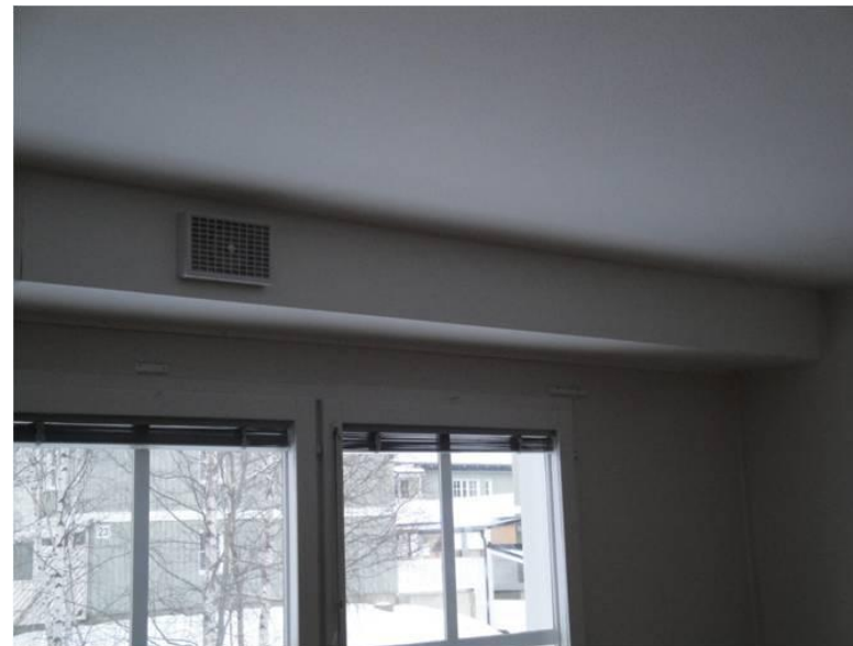
Bild 8. Kanalinklädnad (fabrikat EB Hedlund) med tilluftsdon, monterad utan målningsbättring, Jungfruvägen 9.
