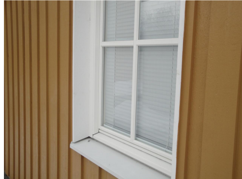
Bild 4. Nytt fönster på Jungfruvägen 117 med aluminiumklädd båge och karm.
