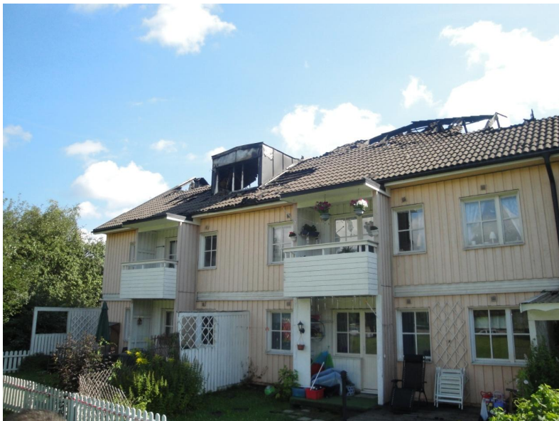
Bild 1. Efter branden juni 2010, vinden nerbrunnen och vattenskador i huset, Jungfruvägen 137.
