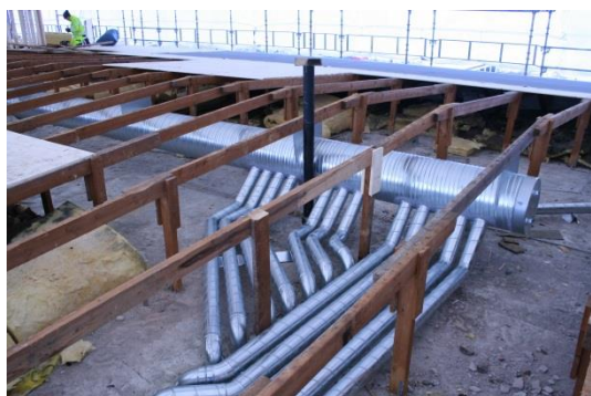
Installation av nya ventilationskanaler på den nya vinden.
