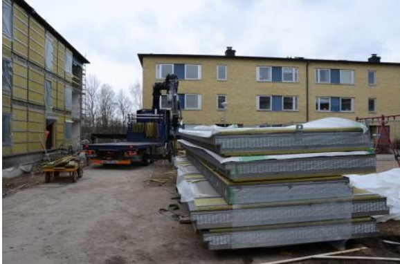
Prefabricerade fasadelement för nästa renoveringsfas.
