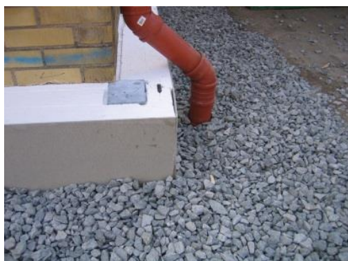
Tilläggsisolering av grunden
