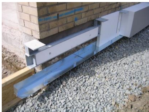
Tilläggsisolering av grunden
