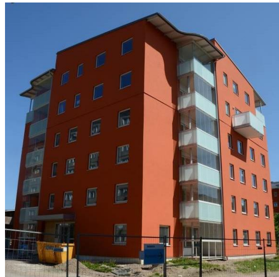
Fortsatt renovering inkl. påbyggnad med två våningar.
