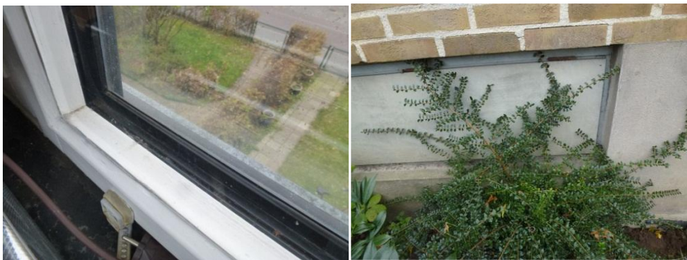
Figur 5 Fönstren bedöms vara originalfönster, av 2-glastyp, 1+1. Majoriteten av fönsterglas till källaren är täckta med utvändig skiva.
