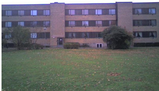
Figur 4 Fasad av tegel och lättbetong resp. endast lättbetong mellan fönster
