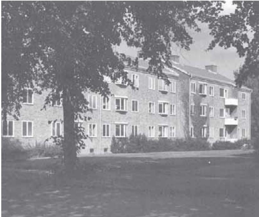
Figur 4. Del av västra Torpa. Foto: Staffan Sedenmalm.
