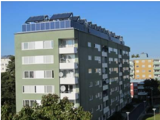
Figur 2. Solfångare på tak, lutande och vertikalt, på byggnad i Husby. Svenska Bostäder. Foto: S. Fristedt.
