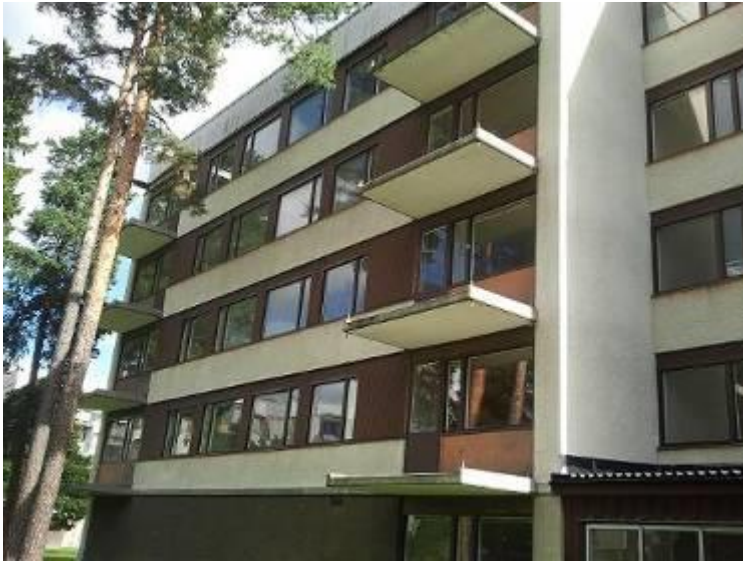
Figur 7. Nya balkonger under byggnad i Sättra Foto: Gavlegårdarna.
