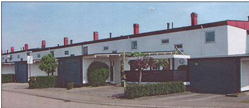
Figur 30. Radhusen mot Helsingborgsvägen.
