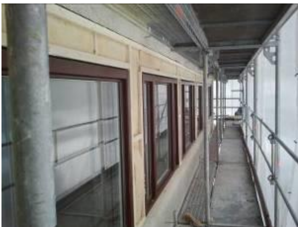
Figur 6. Fönster utflyttade i nytt fasadliv.
