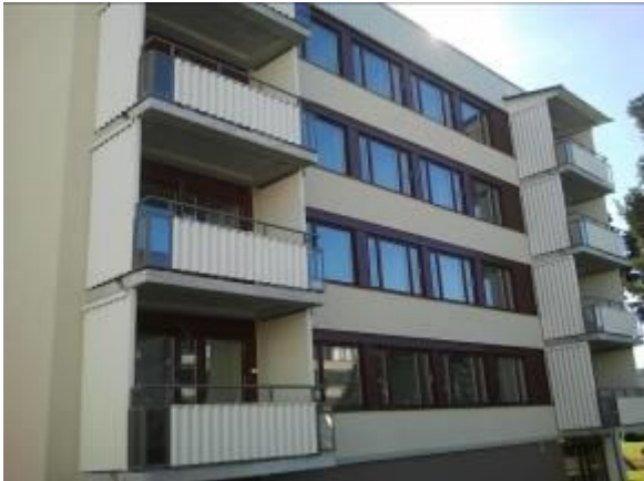
Figur 9. Nya, djupare balkonger i Sätra.
