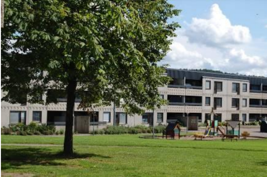
Figur 17. Fasader med de för kv. Skolspåret karakteristiska fasadelementen som isolerande fasad. Foto: Bostads AB Poseidon.
