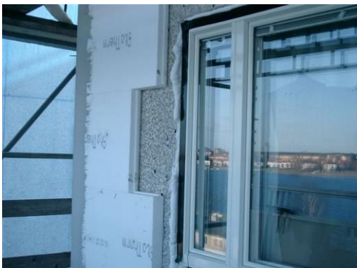
Figur 29. Orrholmen Karlstad. Tilläggsisolering av betongelement. Foto: Rolf Aleskog, KBAB .
