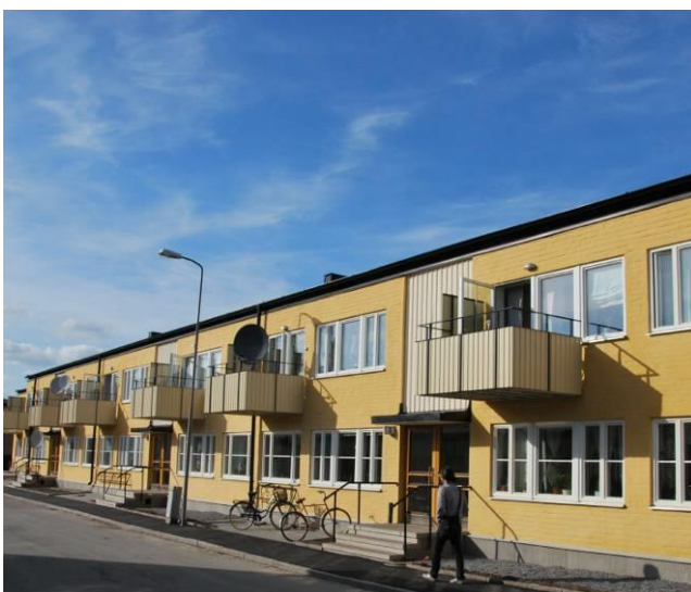
Figur 12. Del av Kvarngärdet i ombyggt skick, Foto: Uppsalahem.
