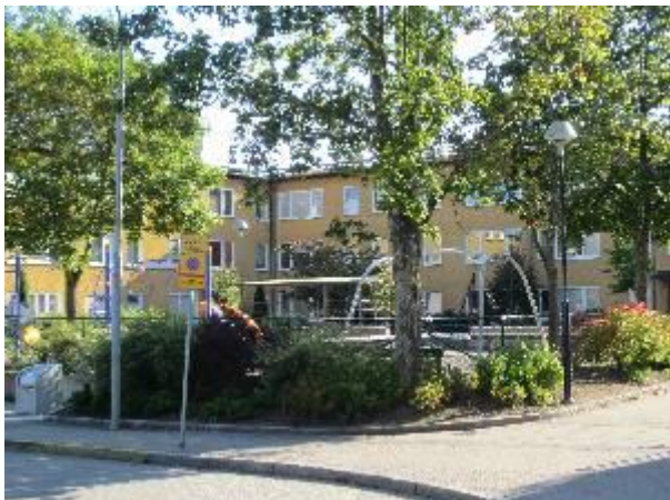
Figur 14. Renoverade och tilläggsisolerade fasader samt upprustad gård i Husby, Foto: Sven Fristedt.
