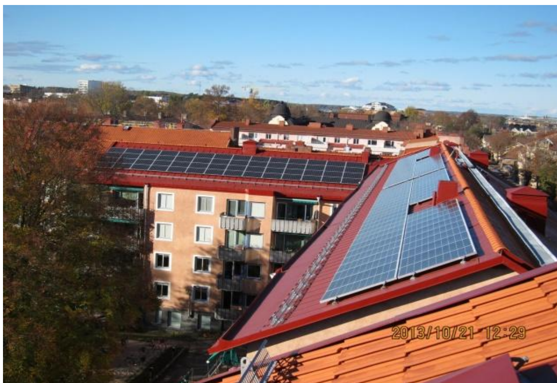
Bild 7. Bilden visar solcellsanläggningen på Brf Granegården. Fotograf Jan Lemming
