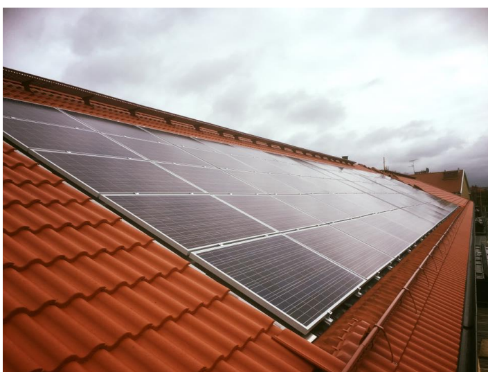
Bild 6. Bilden visar solcellsanläggningen på Brf Krigaren. Bildkälla: Nyedal solenergi
