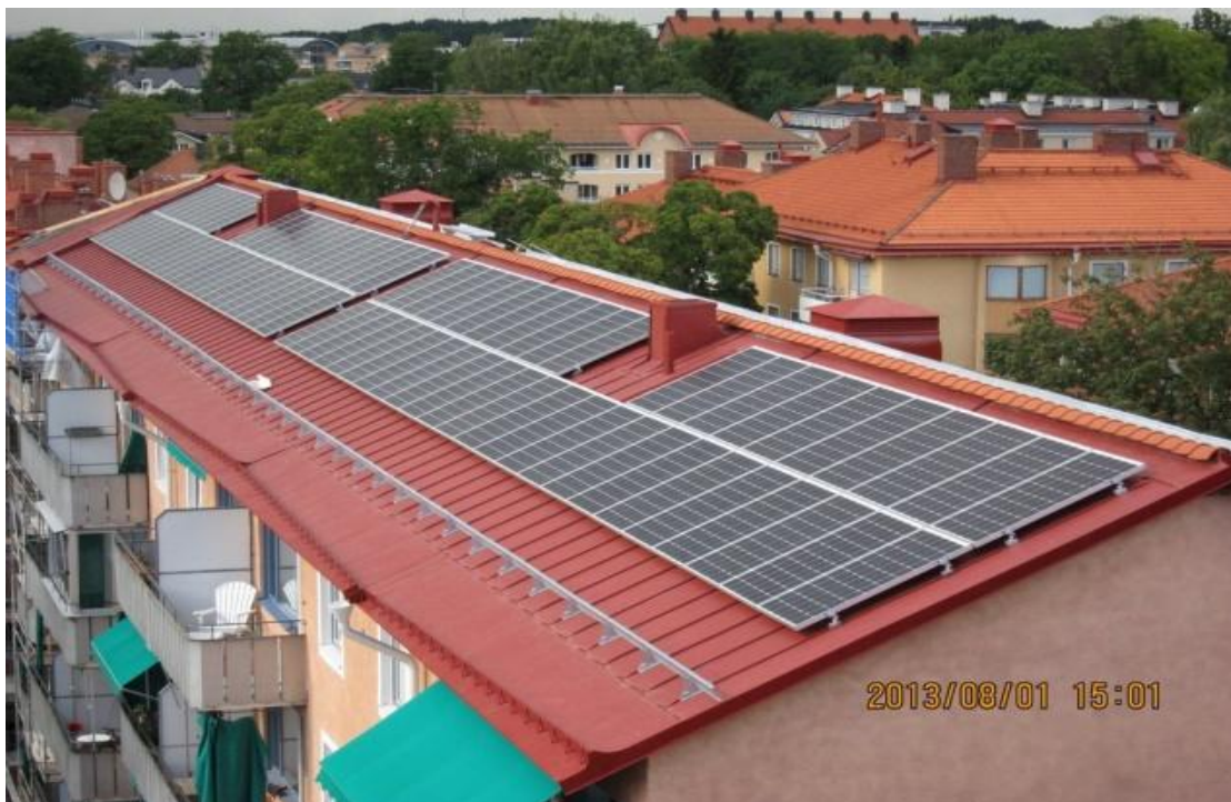
Bild 8. Bilden visar solcellsanläggningen på Brf Granegården. Fotograf Jan Lemming
